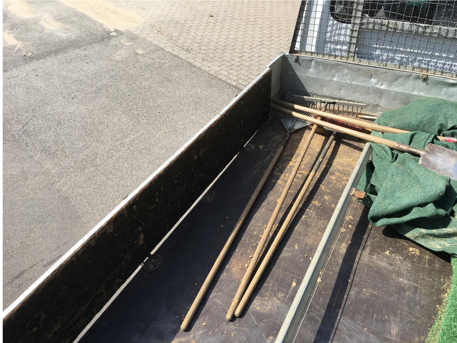
Bild 4, großes Spaltmaß an Bordwand, FR links
