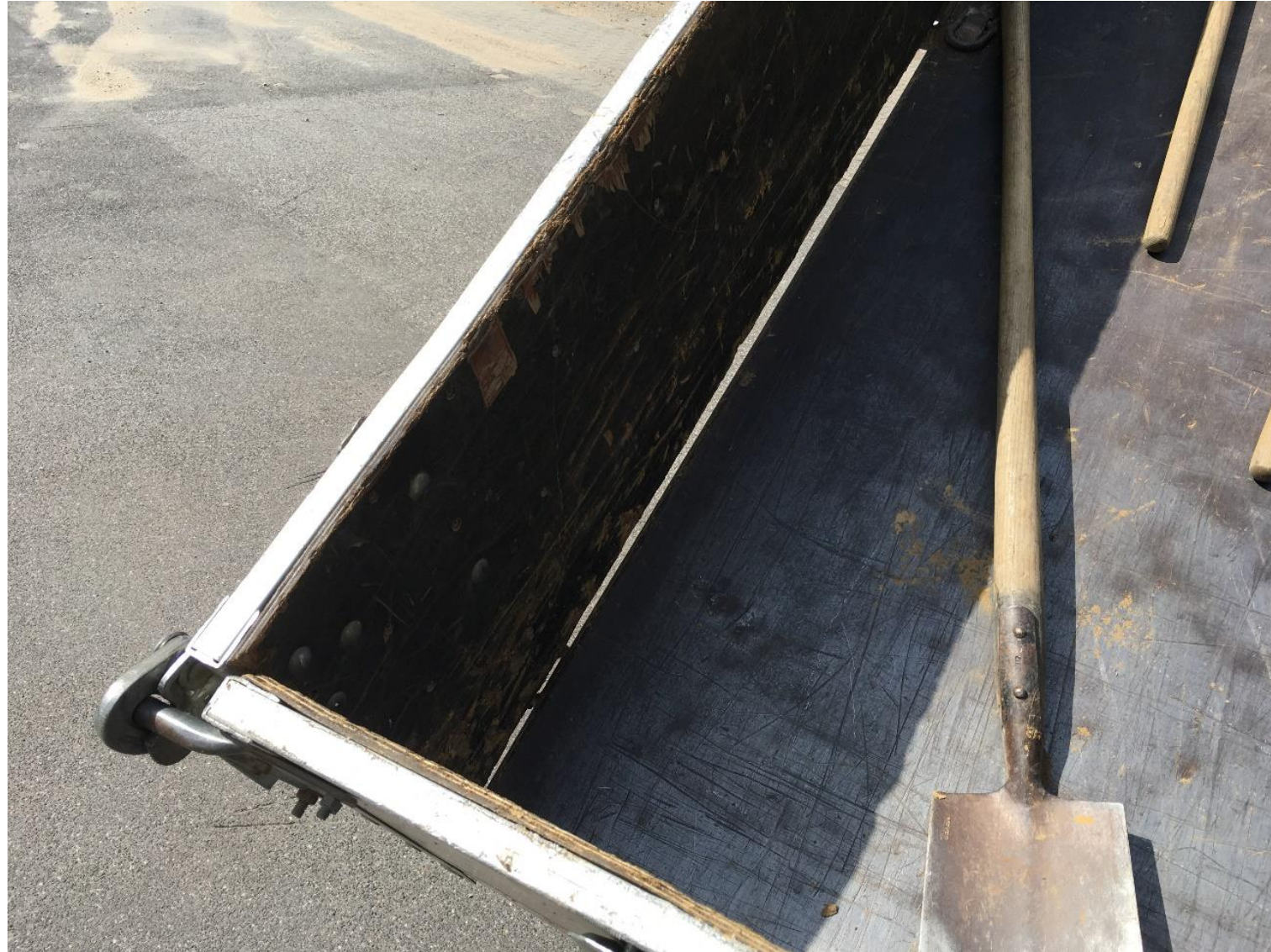
Bild 7, großes Spaltmaß an Bordwand, FR links – Detail 2
