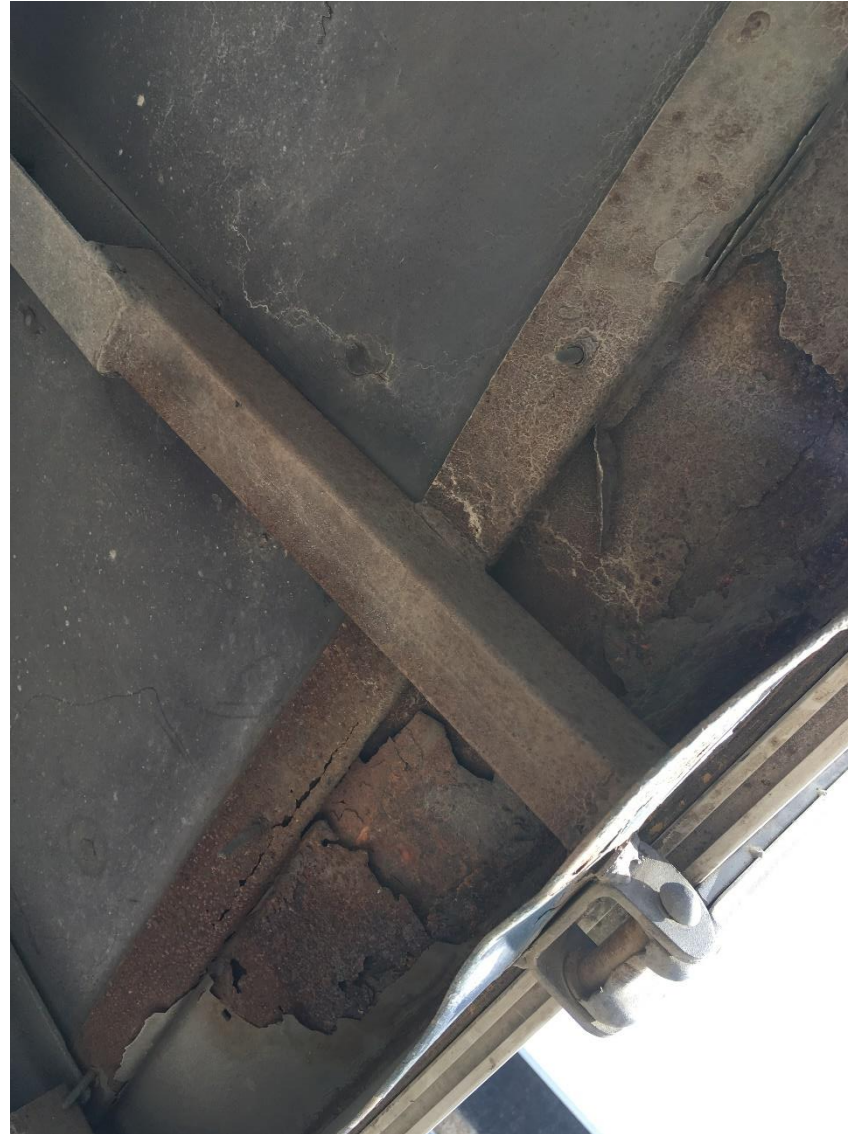
Bild 17, Korrosionsschäden
