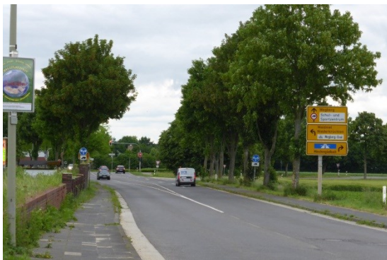
Abbildung 3: Blick in Richtung Grenzlandring
