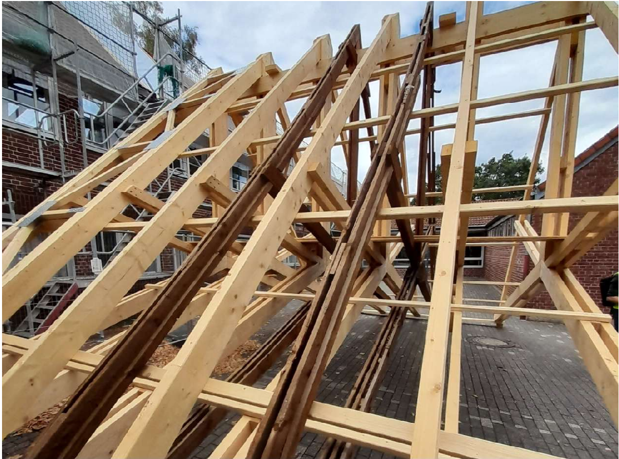
Bild 3: Vormontiertes erstes Binderelement auf der Baustelle mit zwei historischen Bindern
