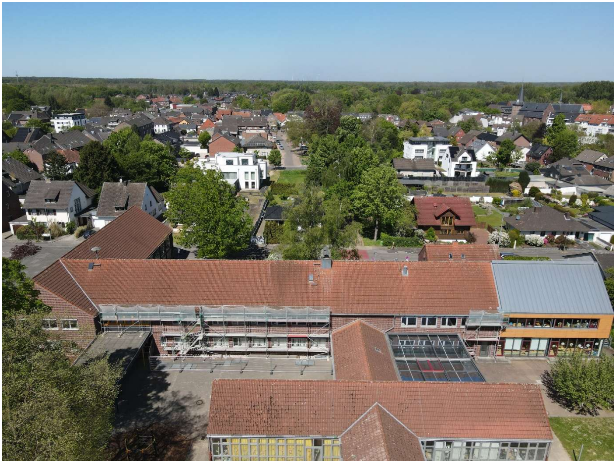
Bild 1: Hauptgebäude Südseite – vor Baumaßnahme mit Sicherungsgerüsten
