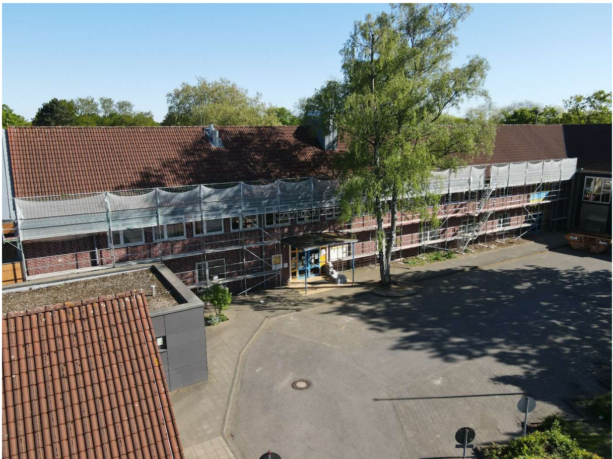
Bild 2: Hauptgebäude Nordseite – vor Baumaßnahme mit Sicherungsgerüsten
