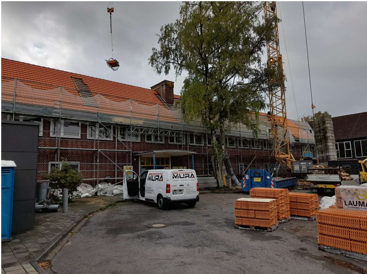
Bild 9: Hauptgebäude Nordseite – Eindeckung der Dachfläche
