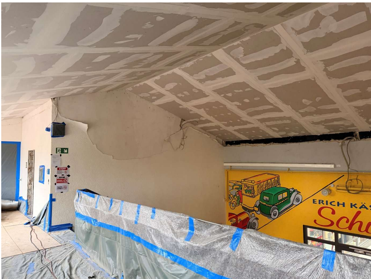
Bild 6: Treppenfoyer 1. Obergeschoss – Einbau der F30-Brandschutzdecke
