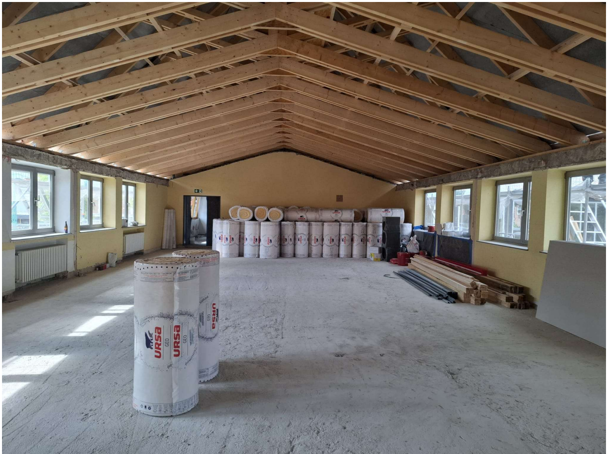
Bild 5: Hauptgebäude 1. Obergeschoss – Raum des geplanten „neuen“ Lehrerzimmers
