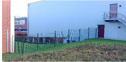
Sporthalle Schule am Grenzlandring
