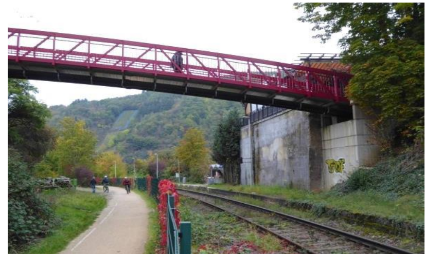
Bild 11: Bahntrasse unter der Merbecker Straße in Wegberg-Asbeck; Nutzung der zweiten Gleistrasse im Ahrtal bei Rech/Mayschoss
