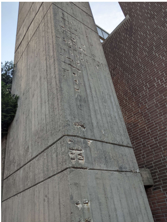
Abplatzungen und Korrosion
