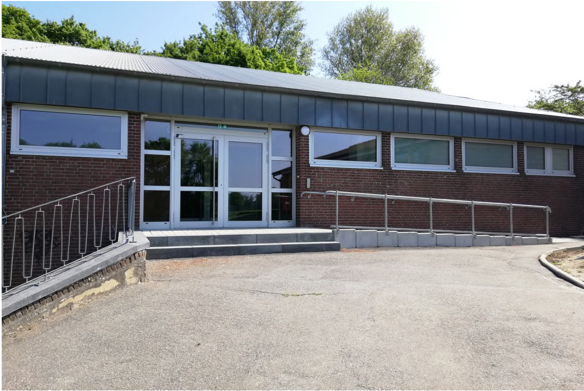
Behinderten- und rollstuhlgerechter Zugang in die Turnhalle
