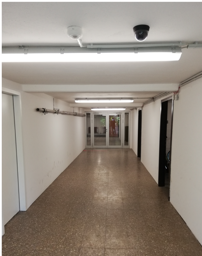
Flur und Fahrradabstellraum im Kellergeschoss
