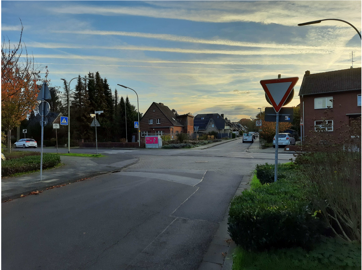
Abbildung 3: Kreuzungsbereich Echter Straße, Masseiker Straße, Gierenstraße. Bei dem Verkehrszeichen 205 müssten das Verkehrszeichen 209 sowie das Zusatzzeichen 1022-10 angebracht werden.
