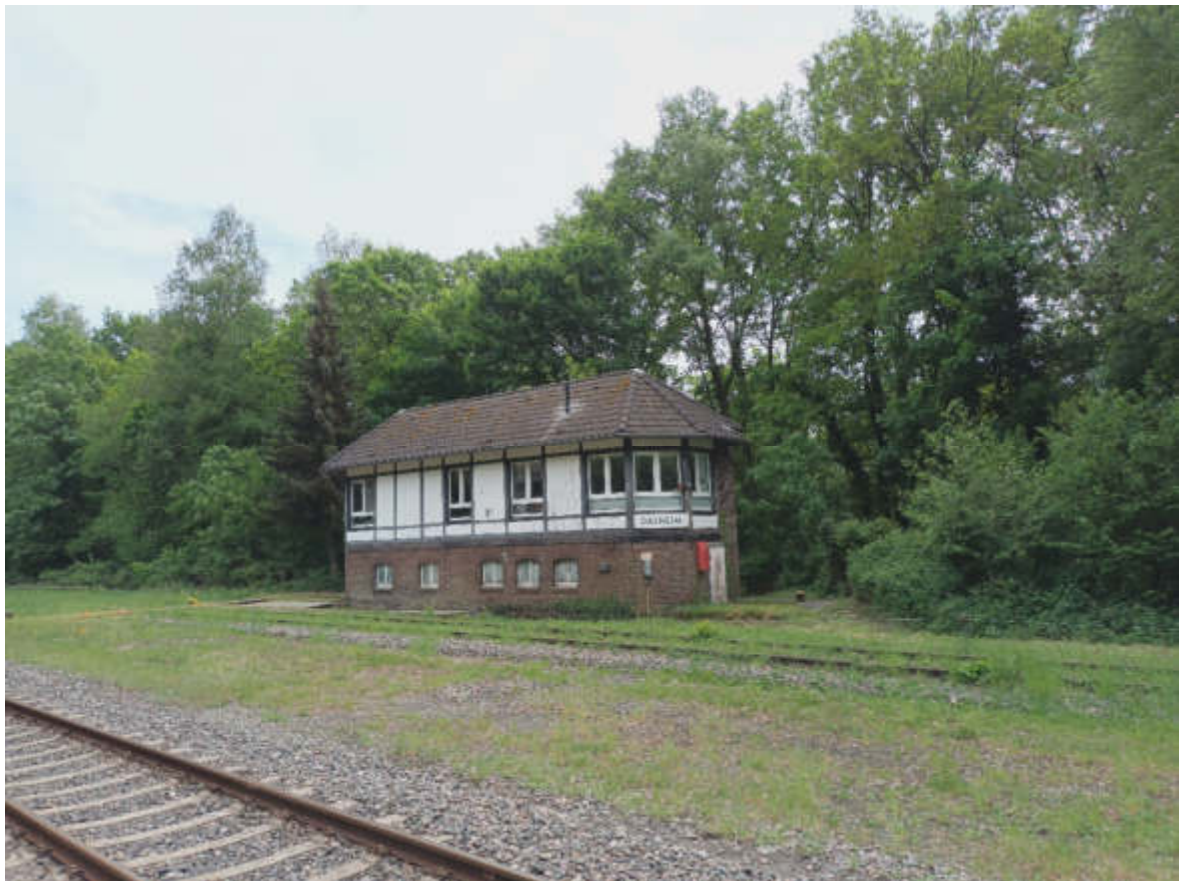
Foto des Stellwerks aus Richtung des Parkplatzes/Buswendeplatz
