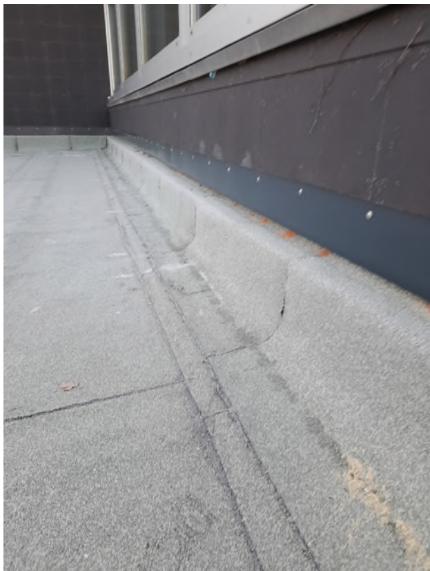
Anschluss an 2-geschossigen Aulabereich
