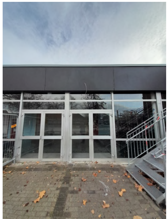
Neue, hinterlüftete Fassadenverkleidung der Attika
