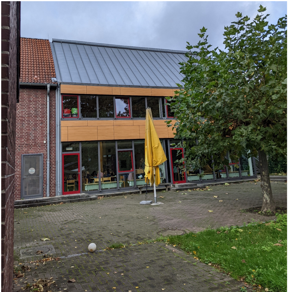
OGS Anbau 2006, Schulgebäude 2-geschossig 1950
