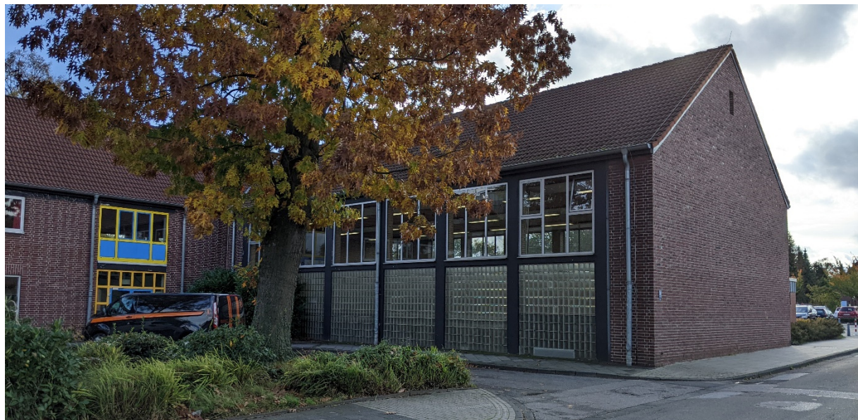
Schulgebäude 2-geschossig 1950, Turnhalle 1950
