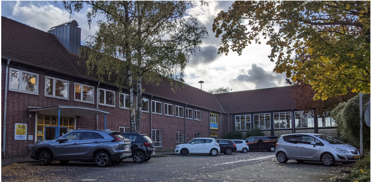
Haupteingang Schulgebäude 2-geschossig 1950, Turnhalle 1950
