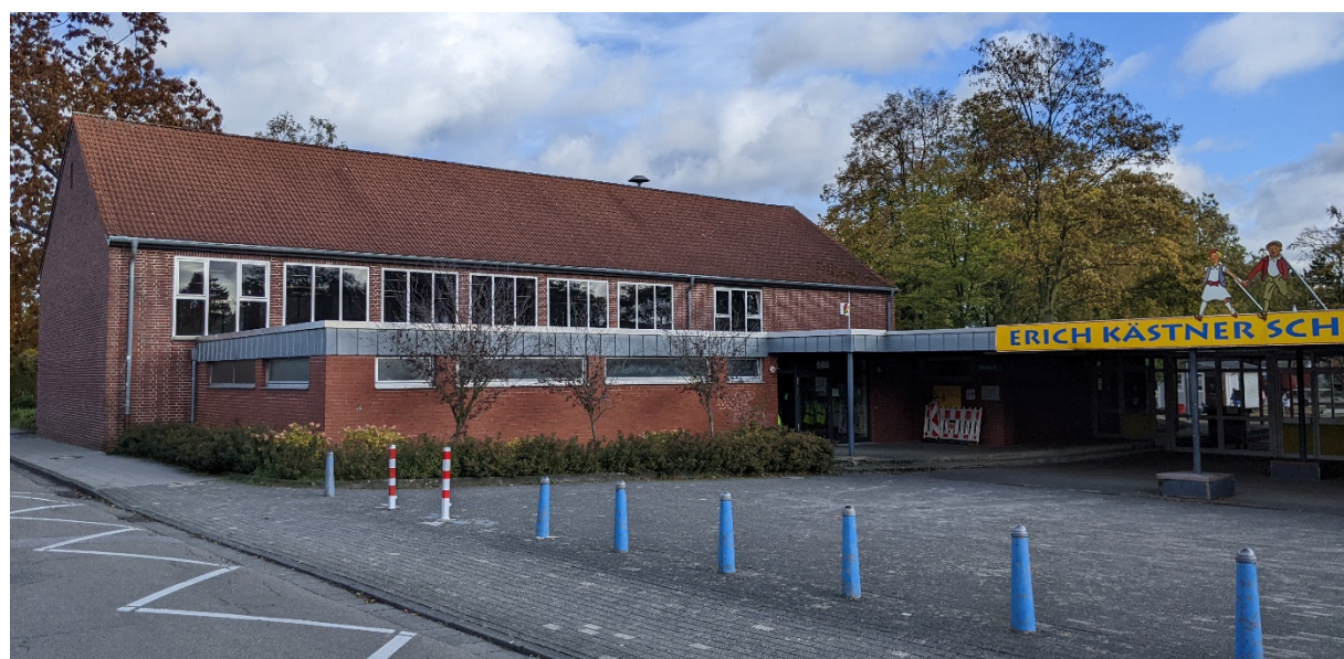
Turnhalle 1950, Umkleide- & Sanitärtrakt 1972, Pausenhofüberdachung 1972
