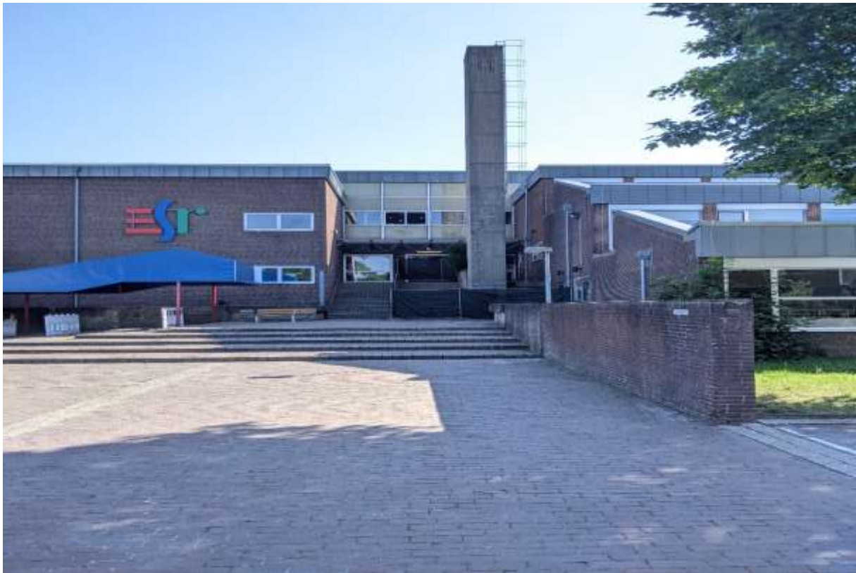
Vor dem Abbruch
