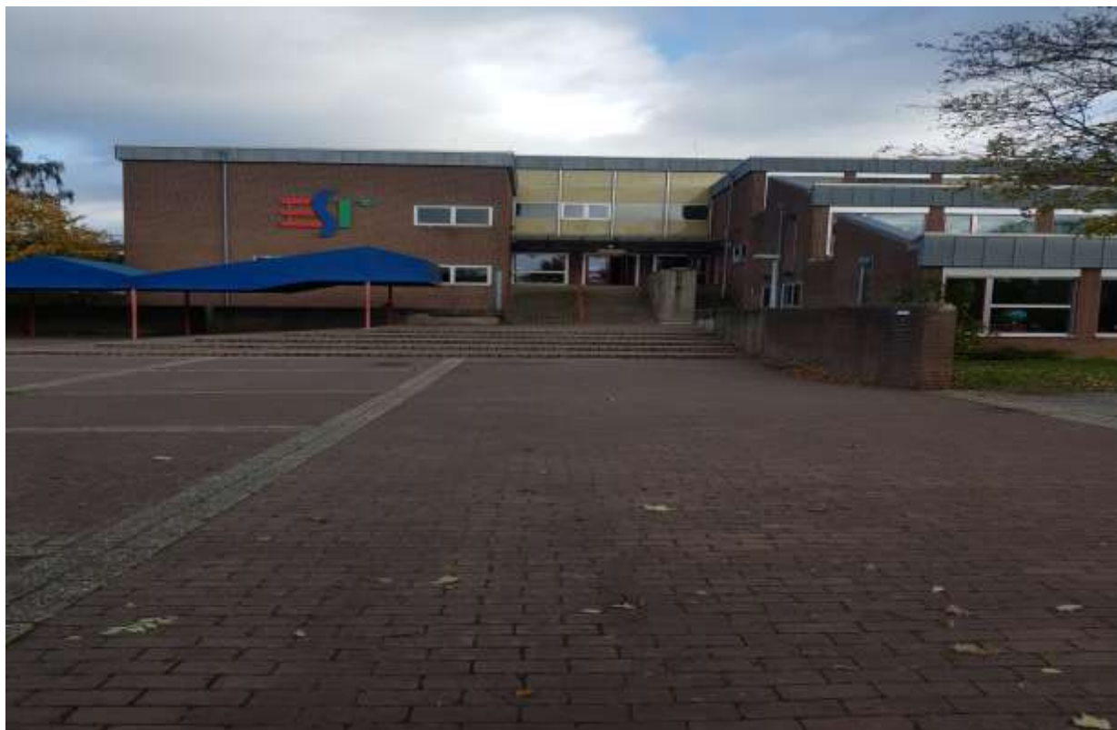
Nach dem Abbruch
