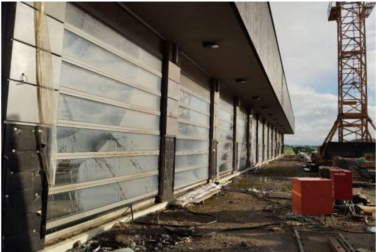
Vorderseitige Fassade mit Sektionaltoren der Fahrzeughalle
