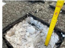
Abbildung 27: Dachflächenbildung S1 - Styroporunterlage
