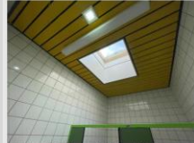
Abbildung 16: Deckenkonstruktion mit Alupanelen
