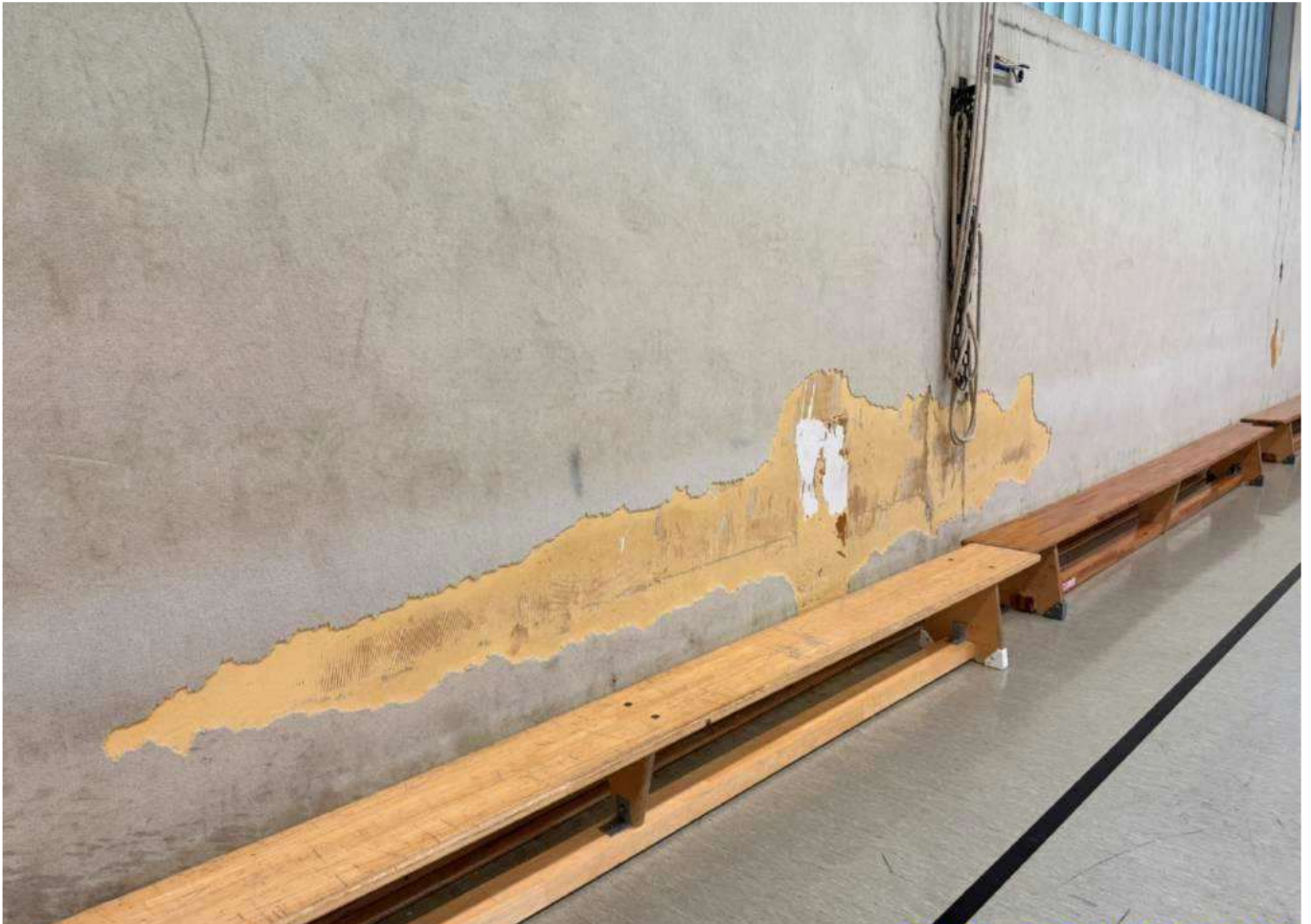
3 Halle Innenraum - Wandschutz
