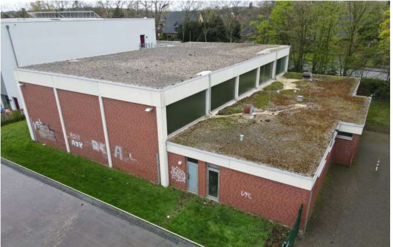
1 Gesamtansicht mit Dachaufsicht
