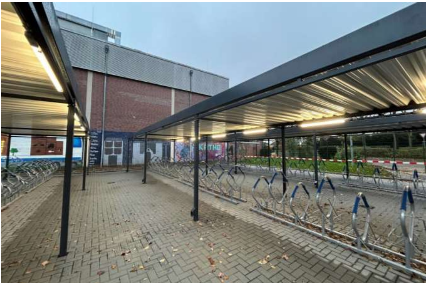
5 Parker mit Beleuchtung (mit Tageslichtsteuerung und Bewegungssensoren)
