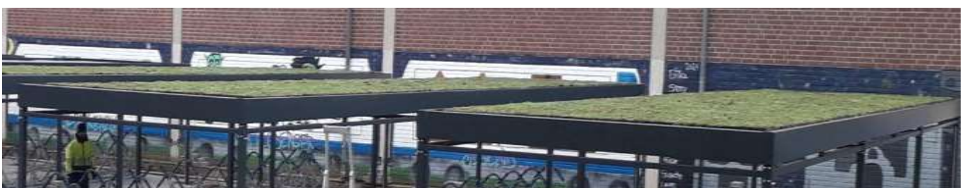
3 Dachaufsicht (ohne Schnee: sichtbare extensive Dachbegrünung)
