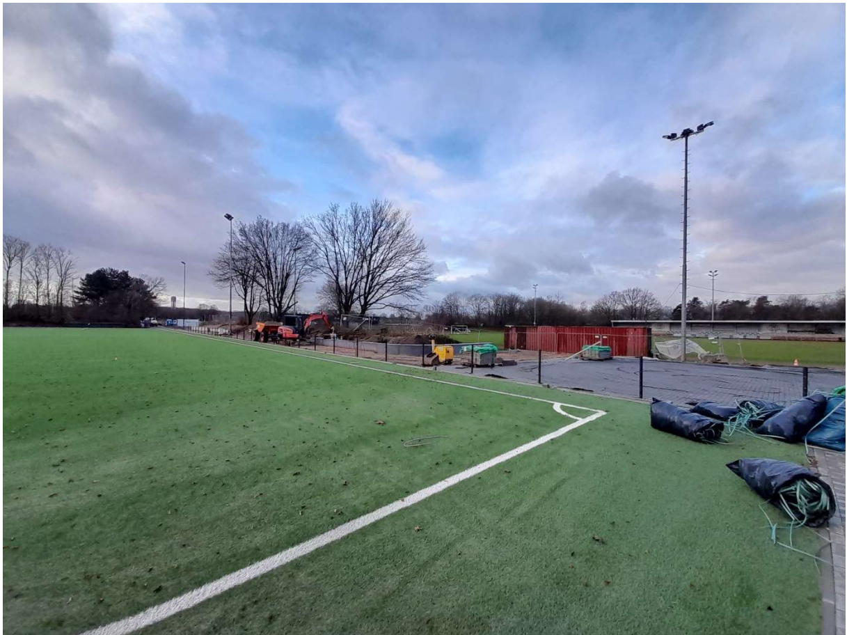
Bild 3: Pflasterarbeiten für neuen Aufenthaltsbereich zwischen Stadion und neuem Kunstrasenplatz
