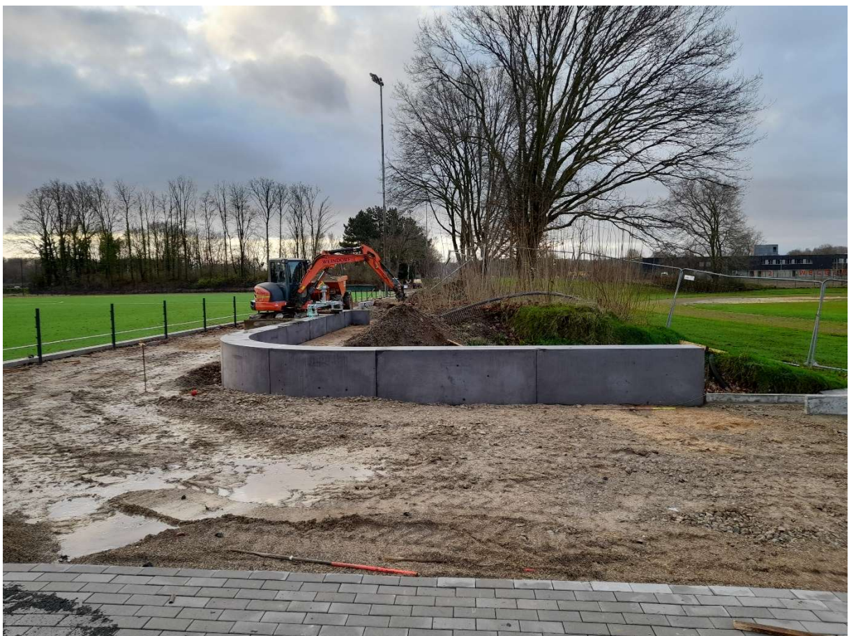
Bild 4: Einbau der neuen Sitzblöcke aus Sichtbetonformteil
