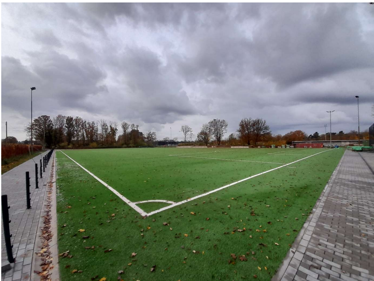
Bild 2: Blick über verlegten Kunststoffrasen in Richtung Hundsportplatz / Hans-Gisbertz-Stadion
