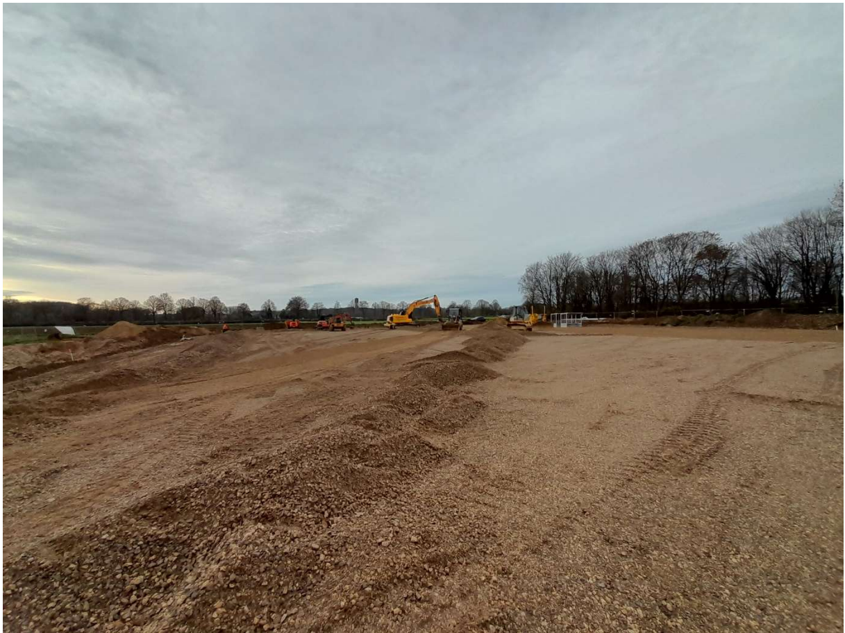
Bild 5: Bodenverbesserung und Unterbau für das neue Juniorenspielfeld
