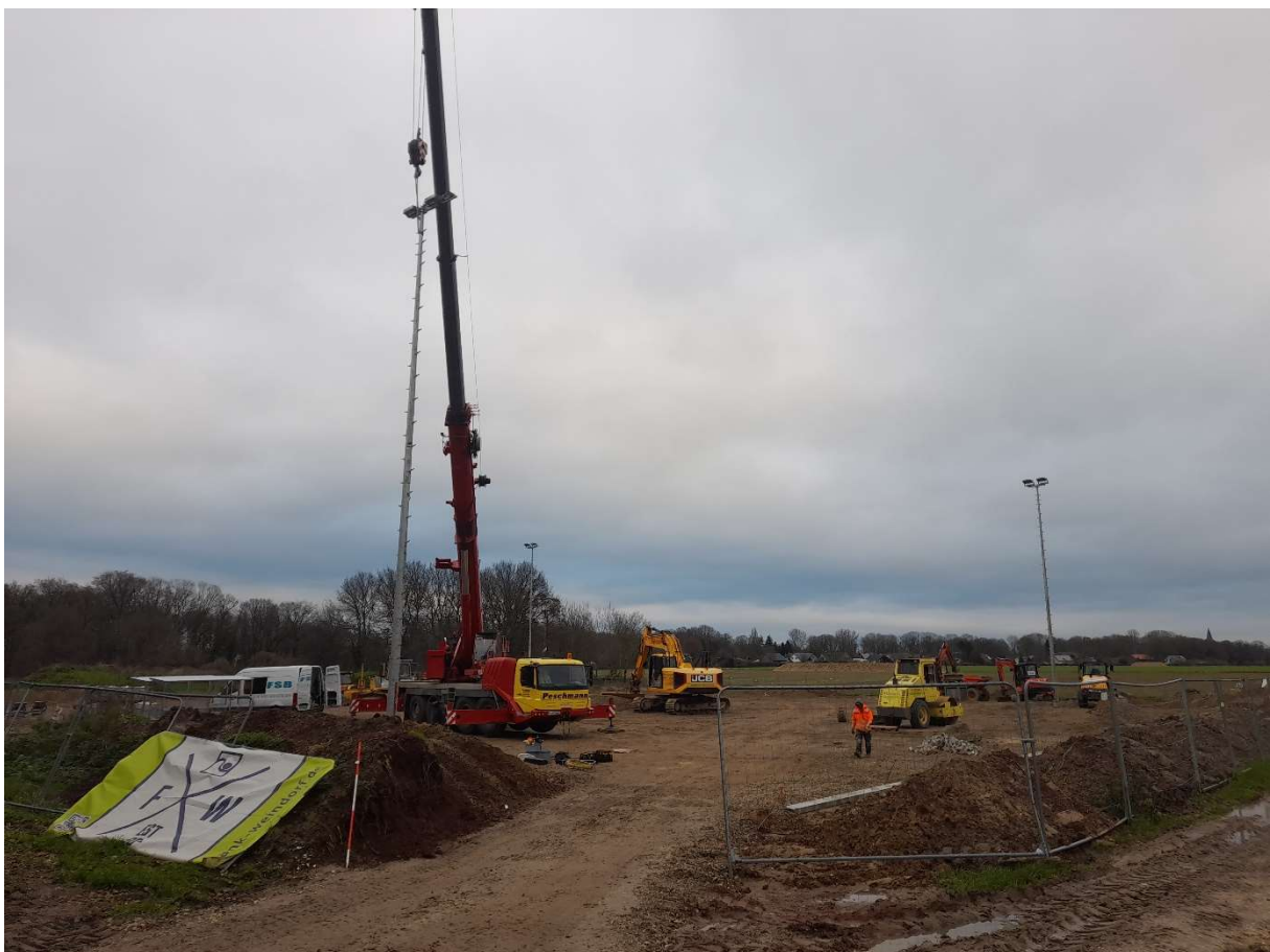
Bild 8: Montage der neuen Flutlichtmasten auf dem zukünftigen Juniorenspielfeld
