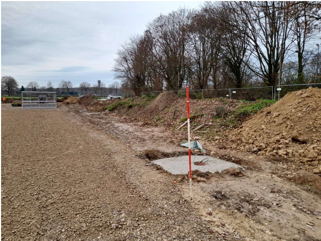
Bild 7: Fundament am Juniorenspielfeld für die neue Flutlichtanlage
