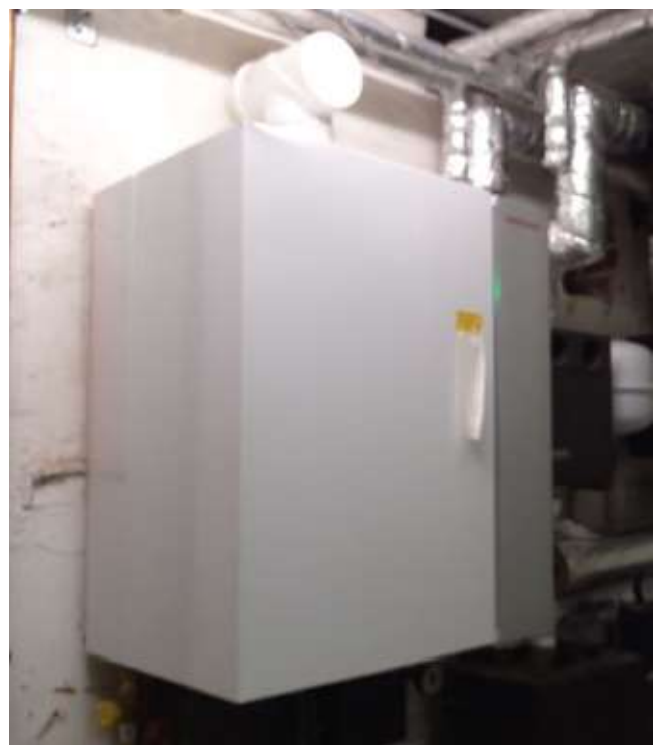
3 Gasbrennwerttherme 45kW
