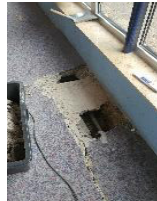
Gebrochene Bodenplatte im Bereich Versorgungsschacht
