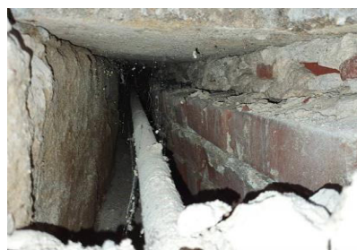
Sichtbarer Querschnitt Versorgungsschacht links Kiesbetonfundament/ rechts Vermauerung Versorgungsschacht
