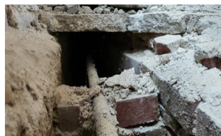
Gebrochene Bodenplatte im Bereich des Versorgungskanals entlang der Fensterfassade
