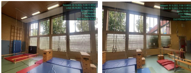
Innenansicht Fensterfassade mit Darstellung der Schutzmaßnahmen Heizkörper
