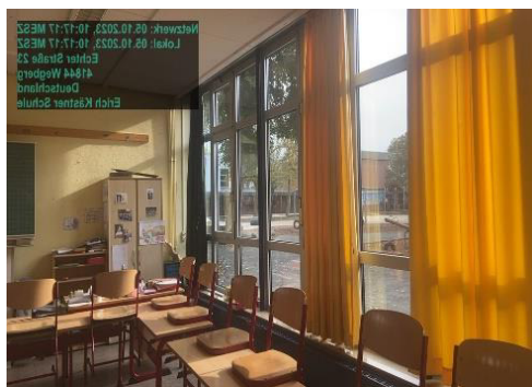
Innenansicht Fensteranlage Pavillonklassen
