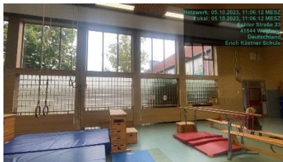
Innenansicht Fassade und Brüstungsverbau
