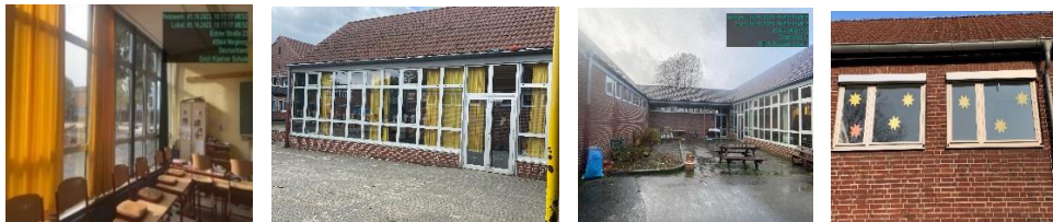
Fensteransichten und beispielhafte nachträgliche Sonnenschutz Installation am Hauptgebäude
