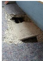
Gebrochene Bodenplatte im Bereich Versorgungsschacht
