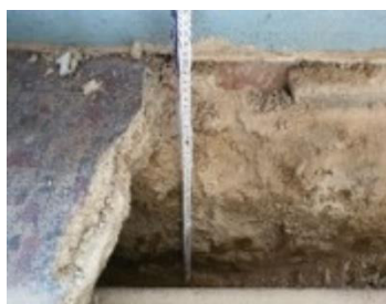
Gebrochene Bodenplatte im Bereich des Versorgungskanals entlang der Fensterfassade
