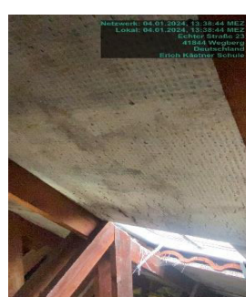
Beschädigte Unterspannbahn unter den Dachpfannen Pavillonklassen
