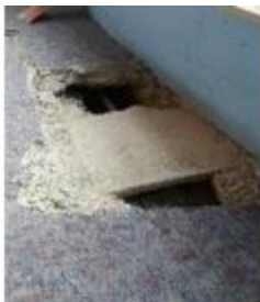
Gebrochene Bodenplatte im Bereich des Versorgungskanals entlang der Fensterfassade
