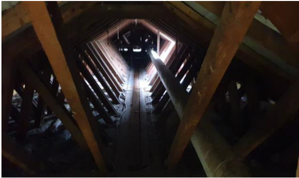
Fachwerkkonstruktion aus Brettbindern von innen.
