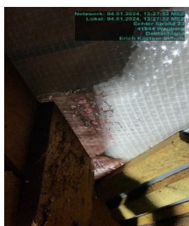
Beschädigte Unterspannbahn unter den Dachpfannen Pavillonklassen
