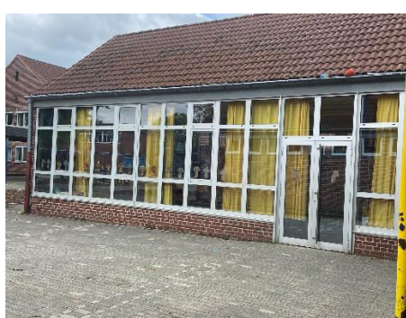
Aussenansicht Fensteranlage Pavillonklassen
