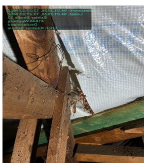
Beschädigte Unterspannbahn unter den Dachpfannen Pavillonklassen
