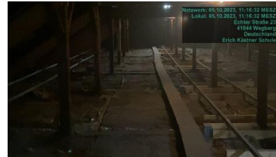
Haltekonstruktion Deckenheizstrahler im Dachraum über Turnhalle
