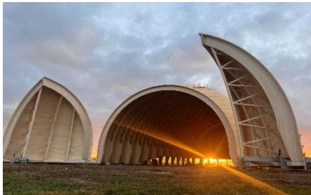
Luftschiffhalle, Mülheim adR
