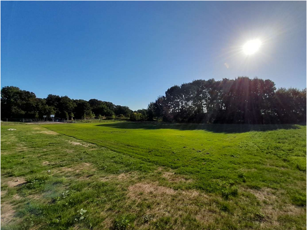
Bild 11: Blick über die neu angelegte Naturrasenfläche für den Bolzplatz (Tore kommen noch)
