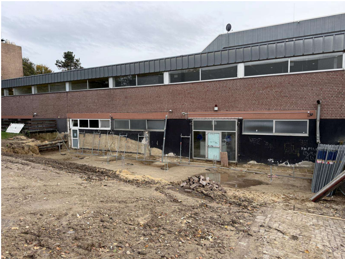
Bild 1: Abbruch ehemaliger Saunaaußenbereich
