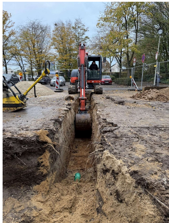
Bild 2+3: Freilegen des Kelleraußenwand und Verlegung neuer Grundleitungen
