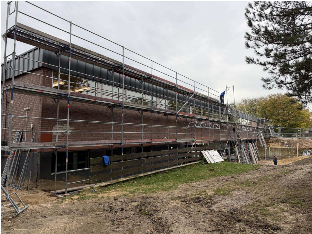
Bild 4: Gerüstbauarbeiten für die Dach- und Fassadenarbeiten (Fassadenseite zur 3-fach-Sporthalle)
