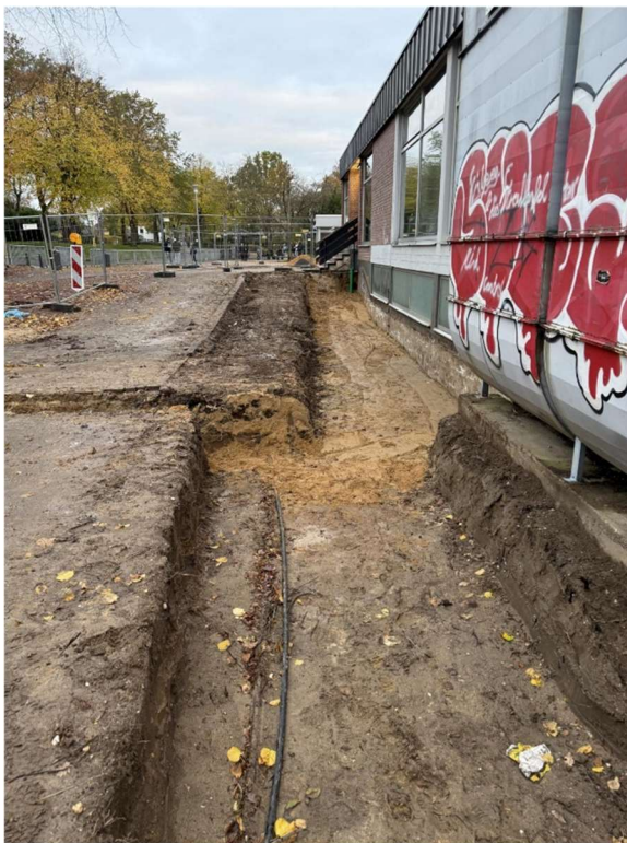
Bild 2+3: Freilegen des Kelleraußenwand und Verlegung neuer Grundleitungen
