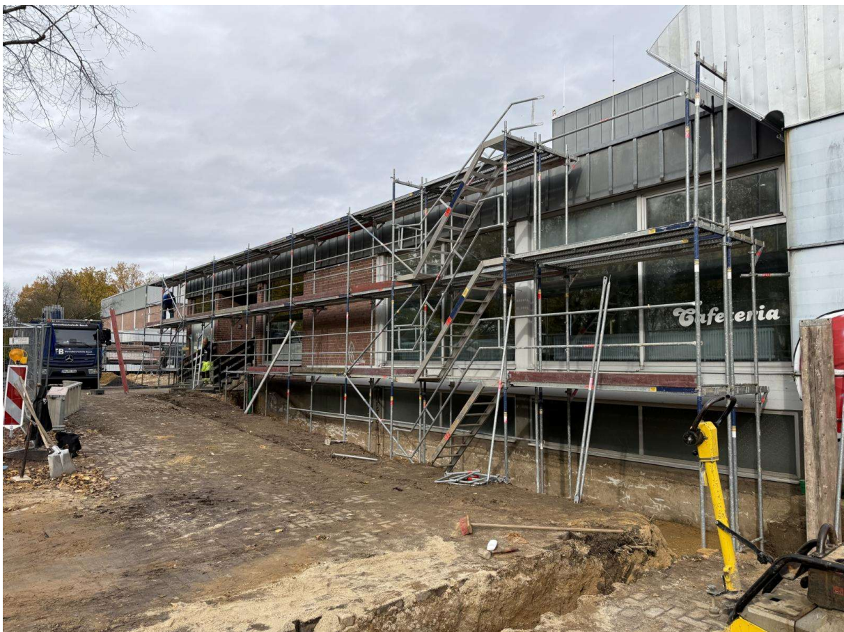
Bild 5: Gerüstbauarbeiten für die Dach- und Fassadenarbeiten (Fassadenseite zur Maaseikerstr.)
