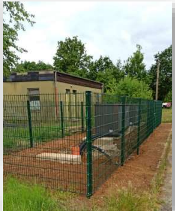
Vorbereitung zur Montage der 3. Außeneinheit
