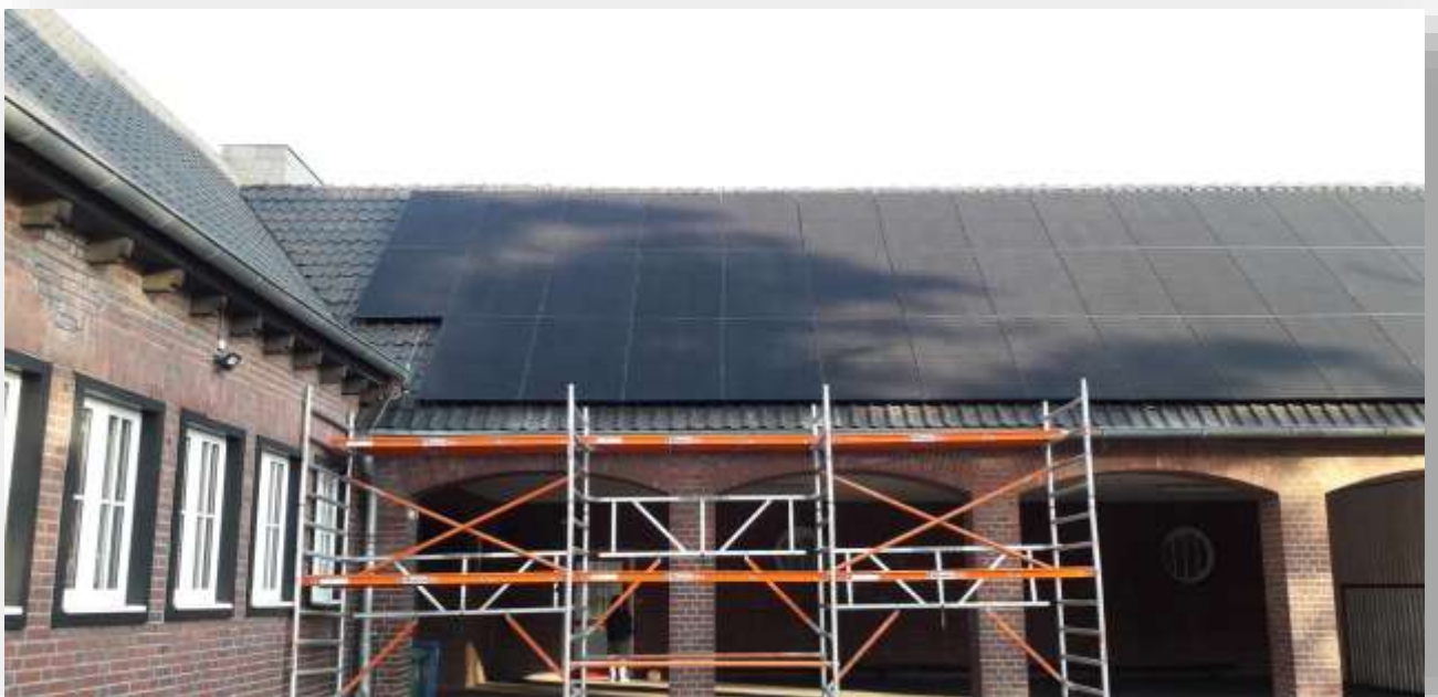
Kurz vor Fertigstellung der Montage
