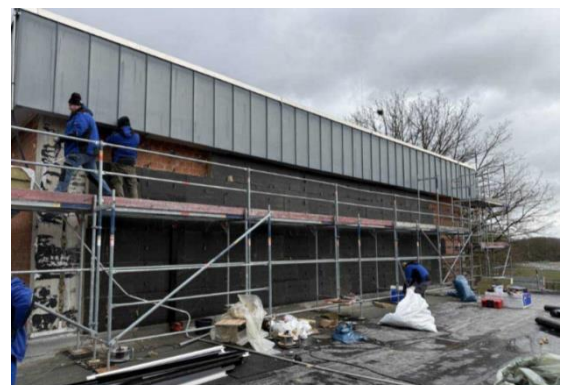
Bild 4: Einbau Fassadendämmung
