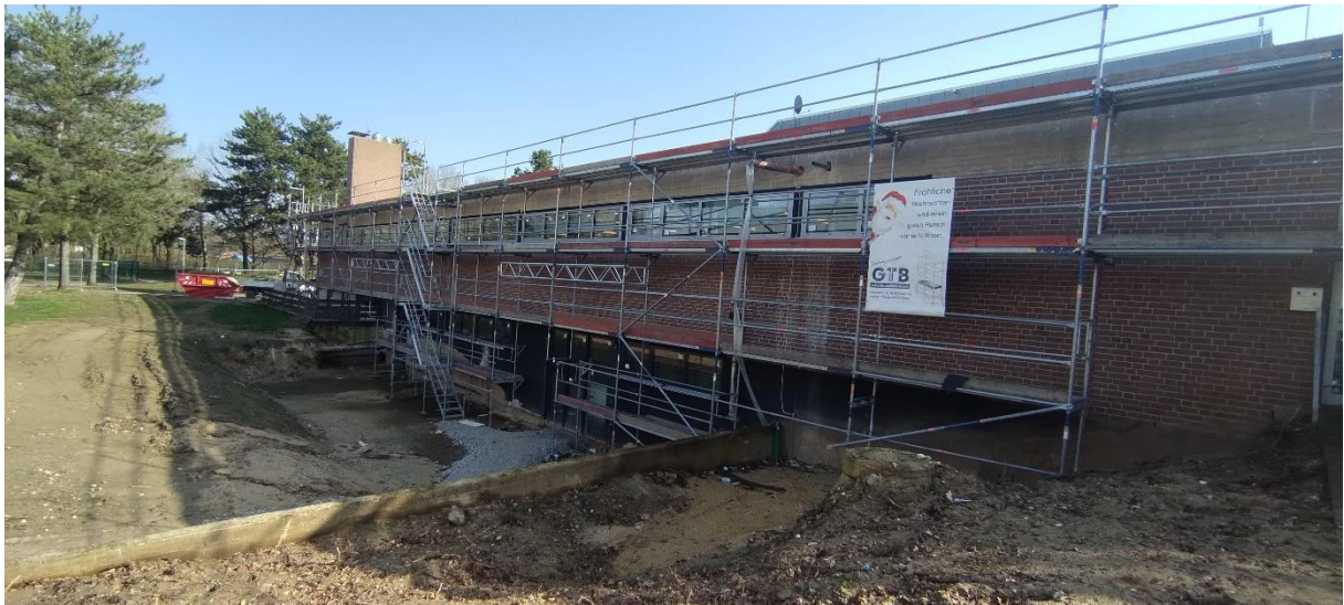
Bild 1: Einbau Fenster- und Türanlagen (Fassadenseite zur 3-fach Sporthalle)
