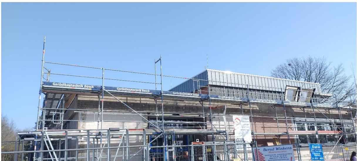
Bild 2: Fassadenarbeiten: Rückbau Klinker – Einbau Fensteranlagen (Fassadenseite zur Maaseikerstr.)
