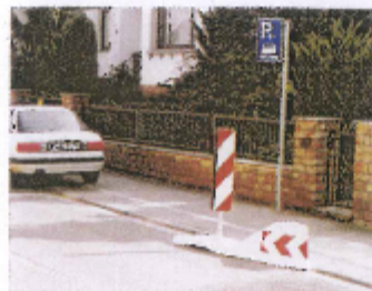
Parkplatzsicherung und Tempohamse die Beruhigungsinsel mit Warnkappe
