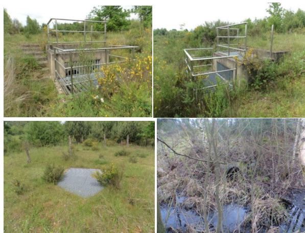
Abschlagbauwerk und Einleitungsstelle in den Helpensteiner Bach
