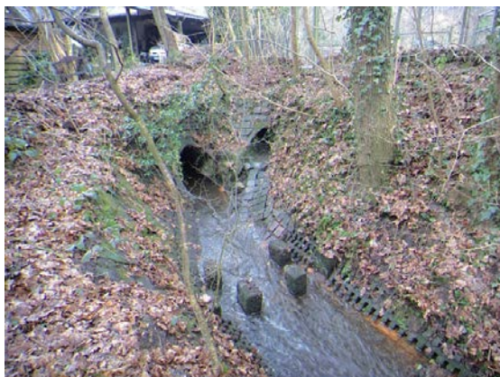
Auslaufbauwerk (rechts) und Einleitungsstelle in den Helpensteiner Bach
