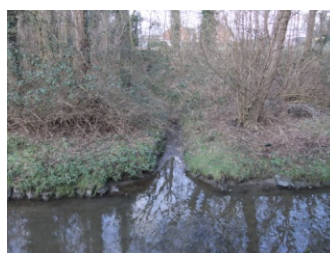
Auslaufbauwerk und Einleitungsstelle in den Beeckbach
