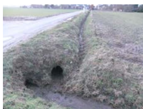
Abschlagsbauwerk und Auslaufbauwerk (rechts)
