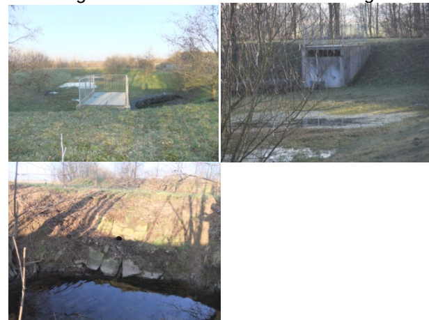
Abschlagsbauwerk und Einleitungsstelle in den Beeckbach
