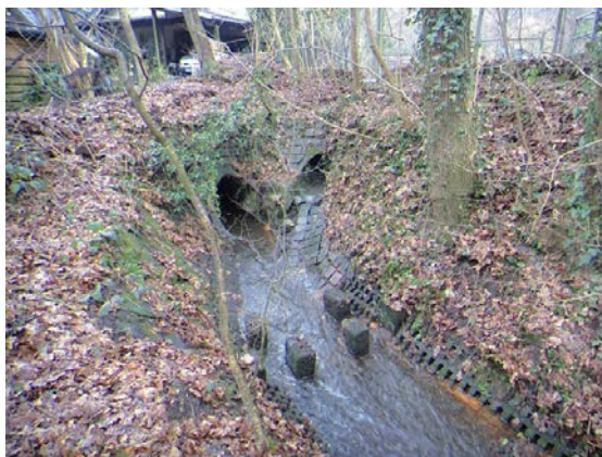
Auslaufbauwerk (rechts) und Einleitungsstelle in den Helpensteiner Bach
