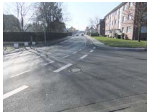
Schachtbauwerk (Süd-West und Nord-Ost)
