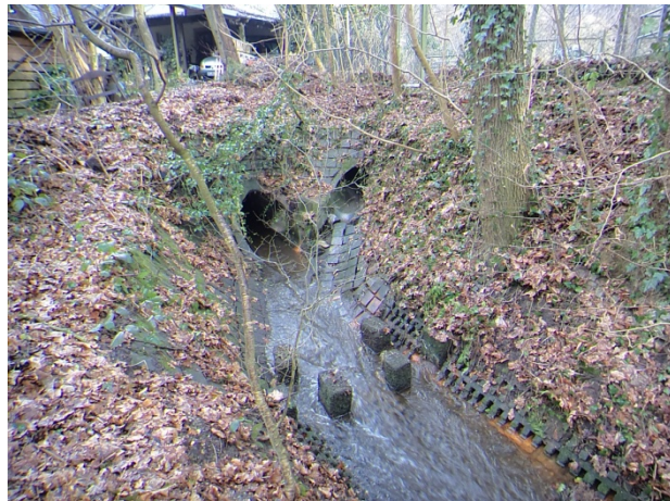
Auslaufbauwerk RÜ 05 = Einleitungsstelle in Helpensteiner Bach (rechts oben)
