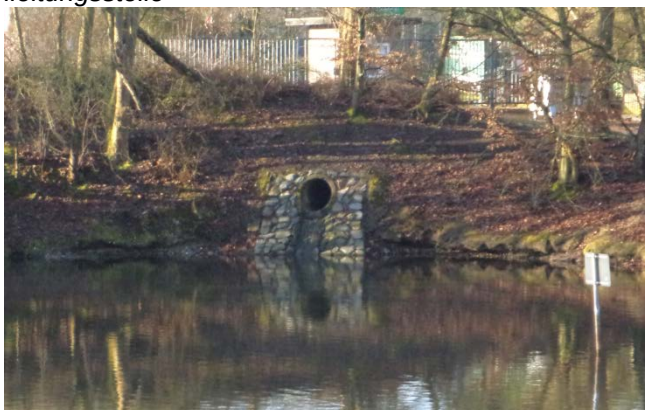
Einleitungsbauwerk in den Ophover Mühlenteich
