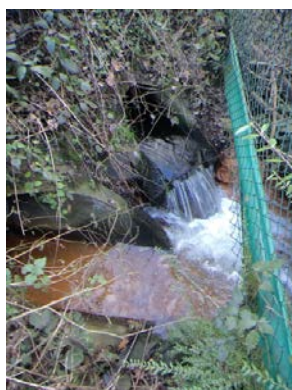
Auslaufbauwerk (links unten)
