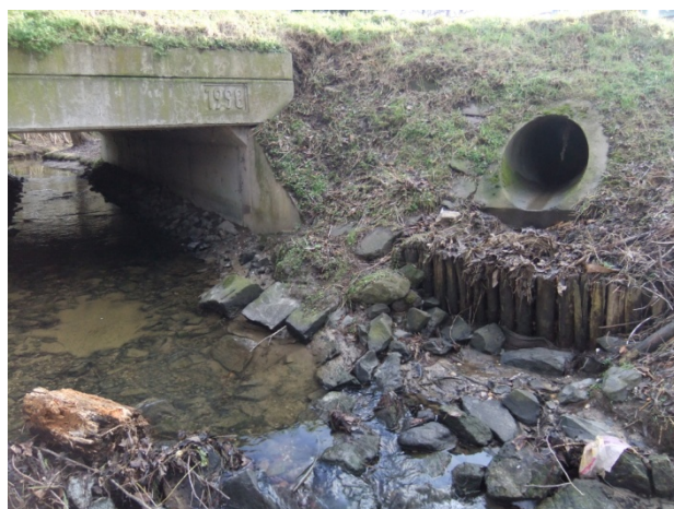
Einleitungsstelle in den Beeckbach in Moorshoven
