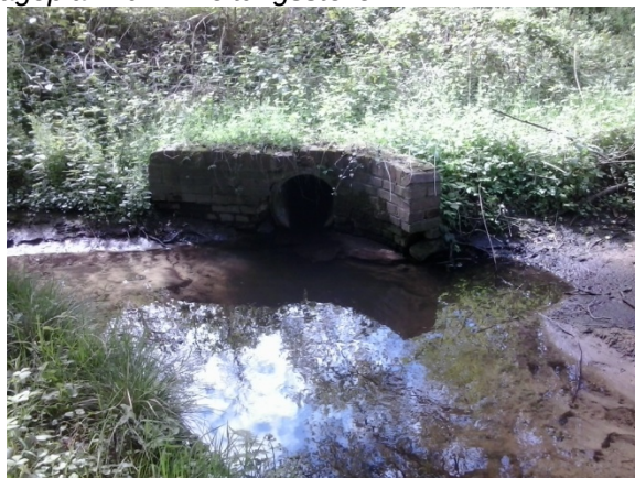
Auslaufbauwerk und Einleitungsstelle in den Rothenbach
