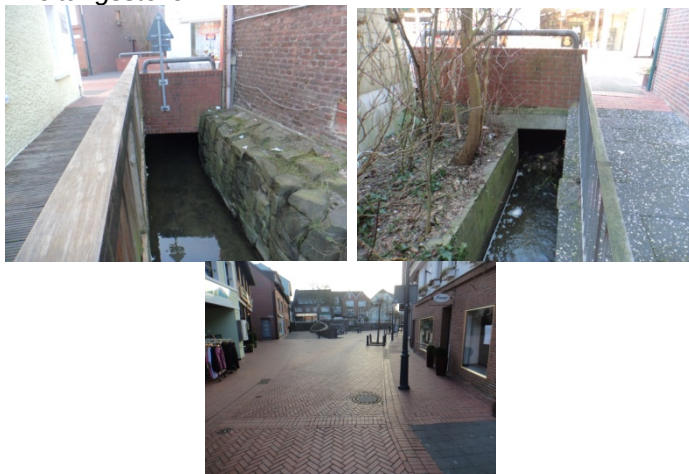
Einleitungsstelle unter der Brücke und Schachtbauwerk
