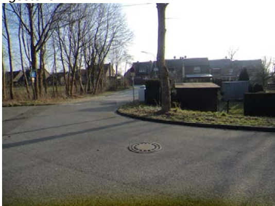
Einleitungsstelle im Bereich der Bachverrohrung mit Blickrichtung nach Süden
