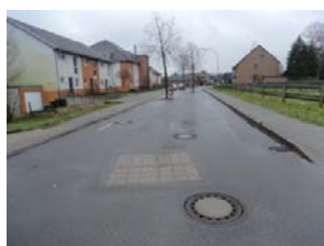
Stauraumkanal und Abschlagsbauwerk
