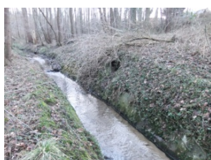
Kontrollschacht und Einleitungsstelle in den Slipsbach
