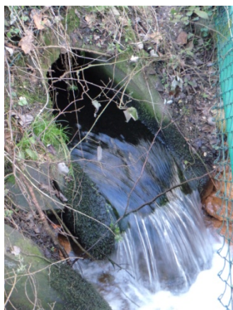
Einleitungsstelle (siehe auch Anlage 2, RÜB 07)
