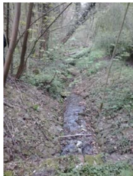
Auslaufbauwerk und Graben in Richtung Einleitungsstelle
