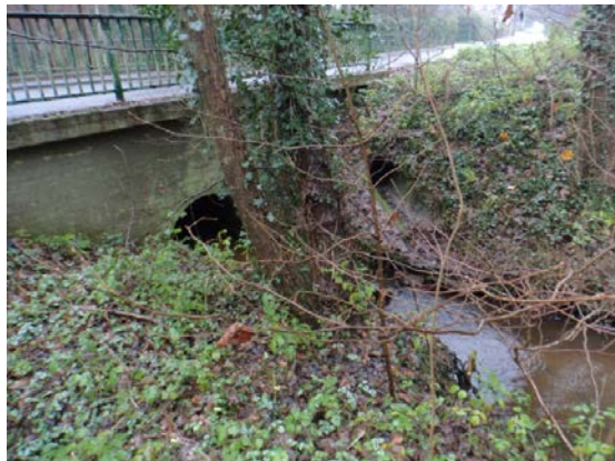
Auslaufbauwerk und Einleitungsstelle (rechts) in den Helpensteiner Bach
