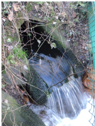
Einleitungsstelle (siehe auch Anlage 2, RÜB 07)
