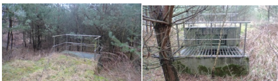
Abschlagsbauwerk und Einleitungsstelle in den Helpensteiner Bach
