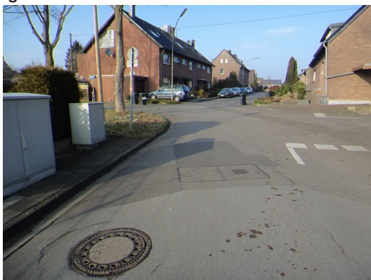
Einleitungsstelle im Bereich der Bachverrohrung mit Blickrichtung nach Norden
