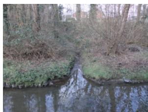
Auslaufbauwerk und Einleitungsstelle in den Beeckbach
