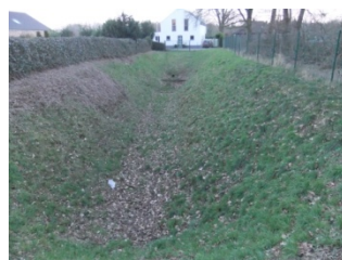
Einleitungsstelle in das Becken und Beckenfläche
