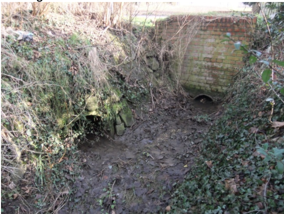
Einleitungsstelle in den Mühlenbach
