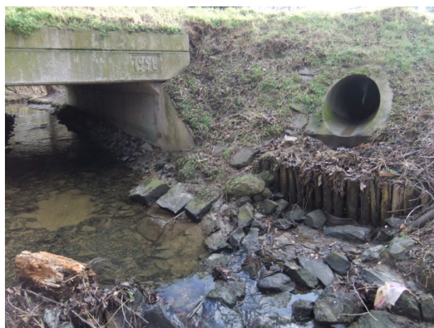
Einleitungsstelle in den Beeckbach in Moorshoven
