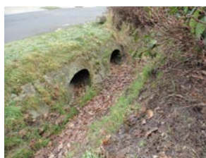
Abschlagsbauwerk und Auslaufbauwerk
