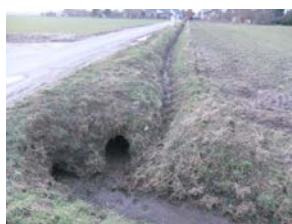
Abschlagsbauwerk und Auslaufbauwerk (rechts)
