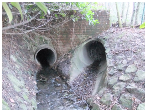
Einleitungsstelle in den Slipsbach (rechts)
