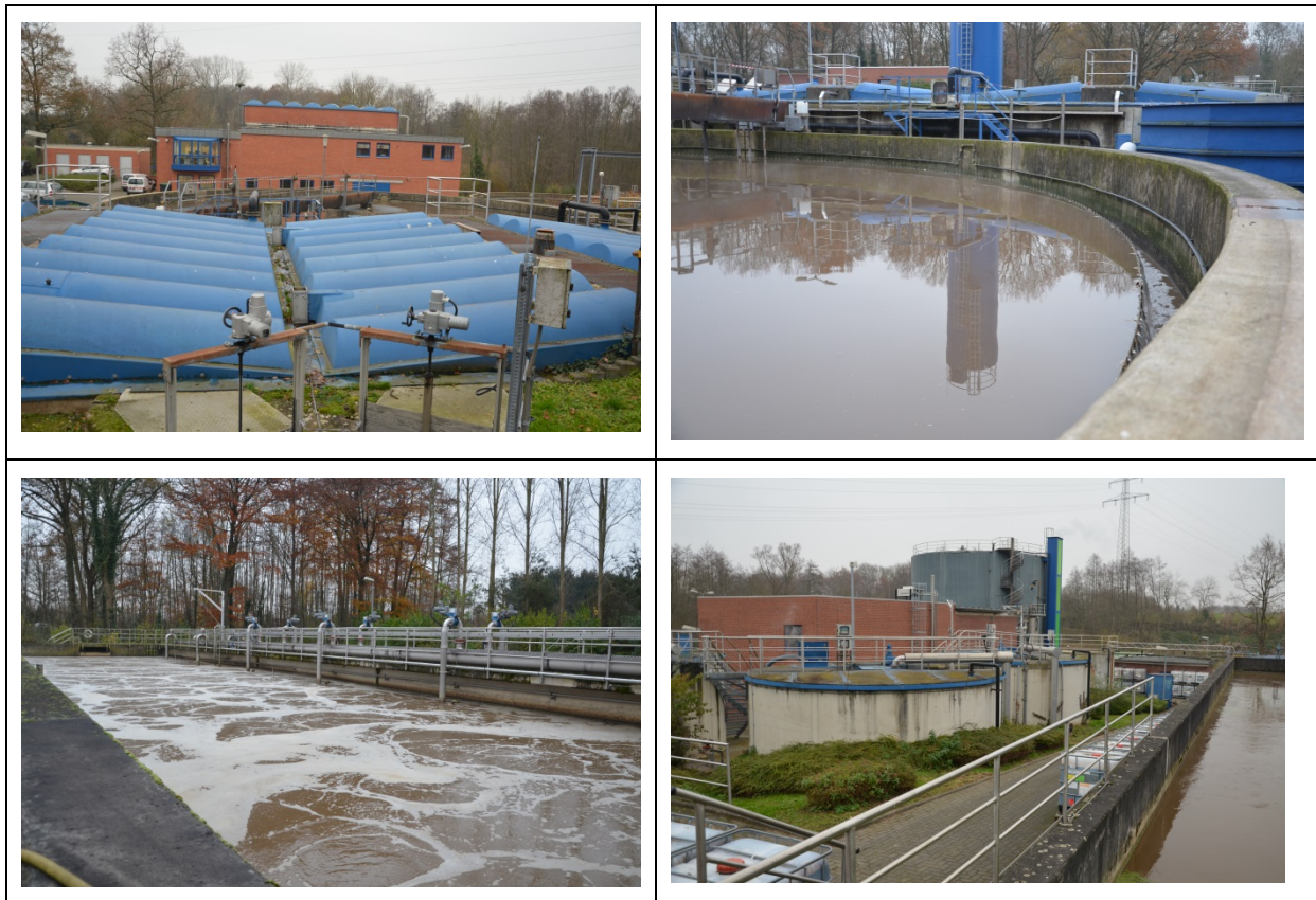
Bild 3-4: Ansichten KA Wegberg, links oben Hochlastbelebung, rechts oben Zwischenklärung, links unten Nitrifikationsstufe, rechts unten Blick von der Deni-Stufe über die Eindicker zum Faulbehälter
