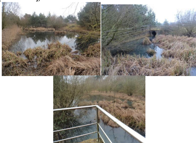
RKB 2 (o.l.), Zulauf/Einleitungsstelle in das Becken (o.r.), Becken vom Zulauf aus gesehen (u.m.)
