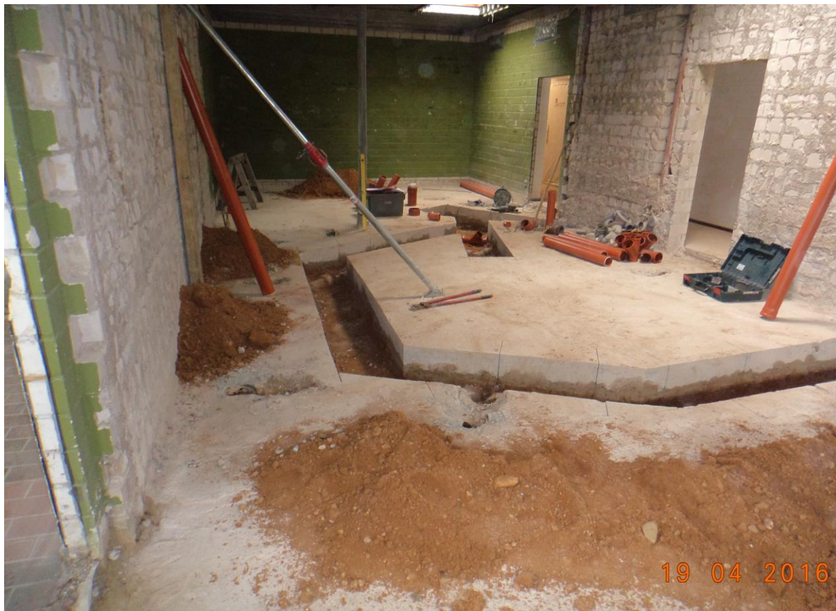
Bild 05: Umkleiden / Duschbereich nach Betonschneidearbeiten
