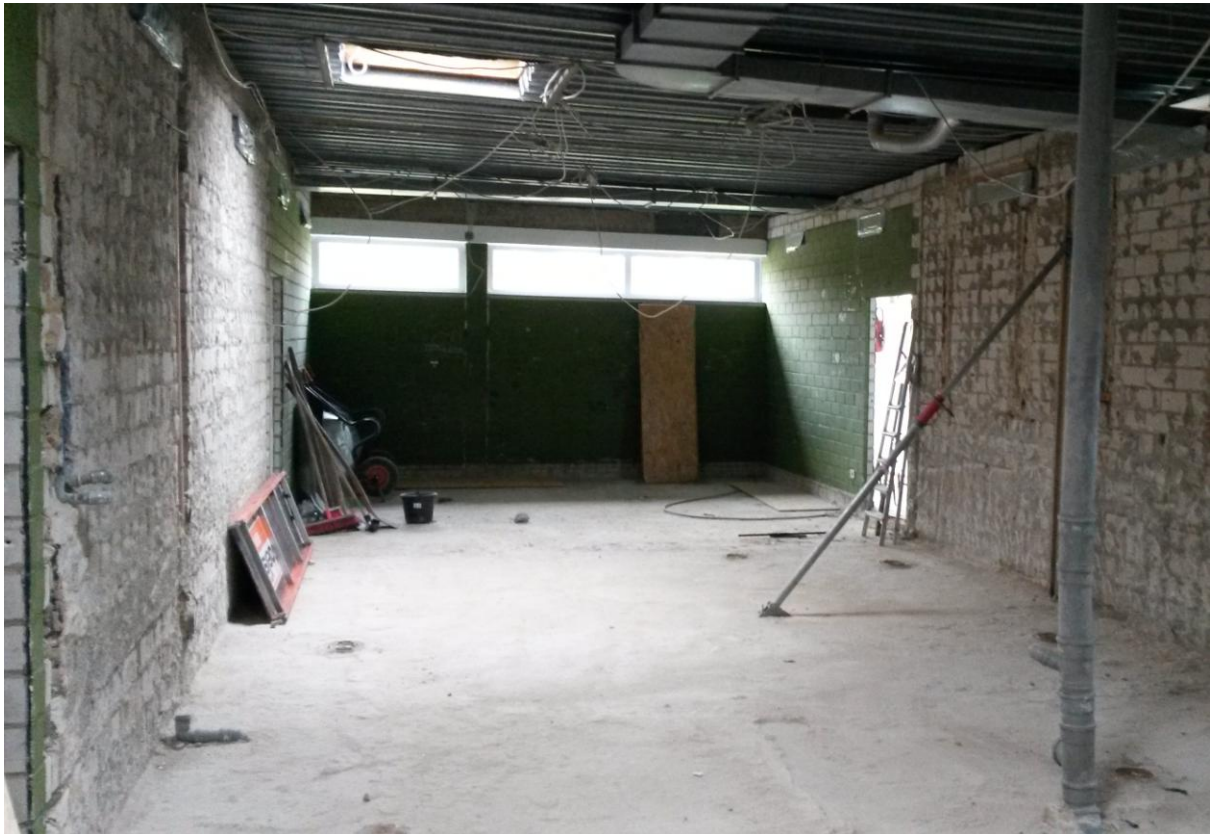
Bild 03: Duschbereiche nach „Entkernung“
