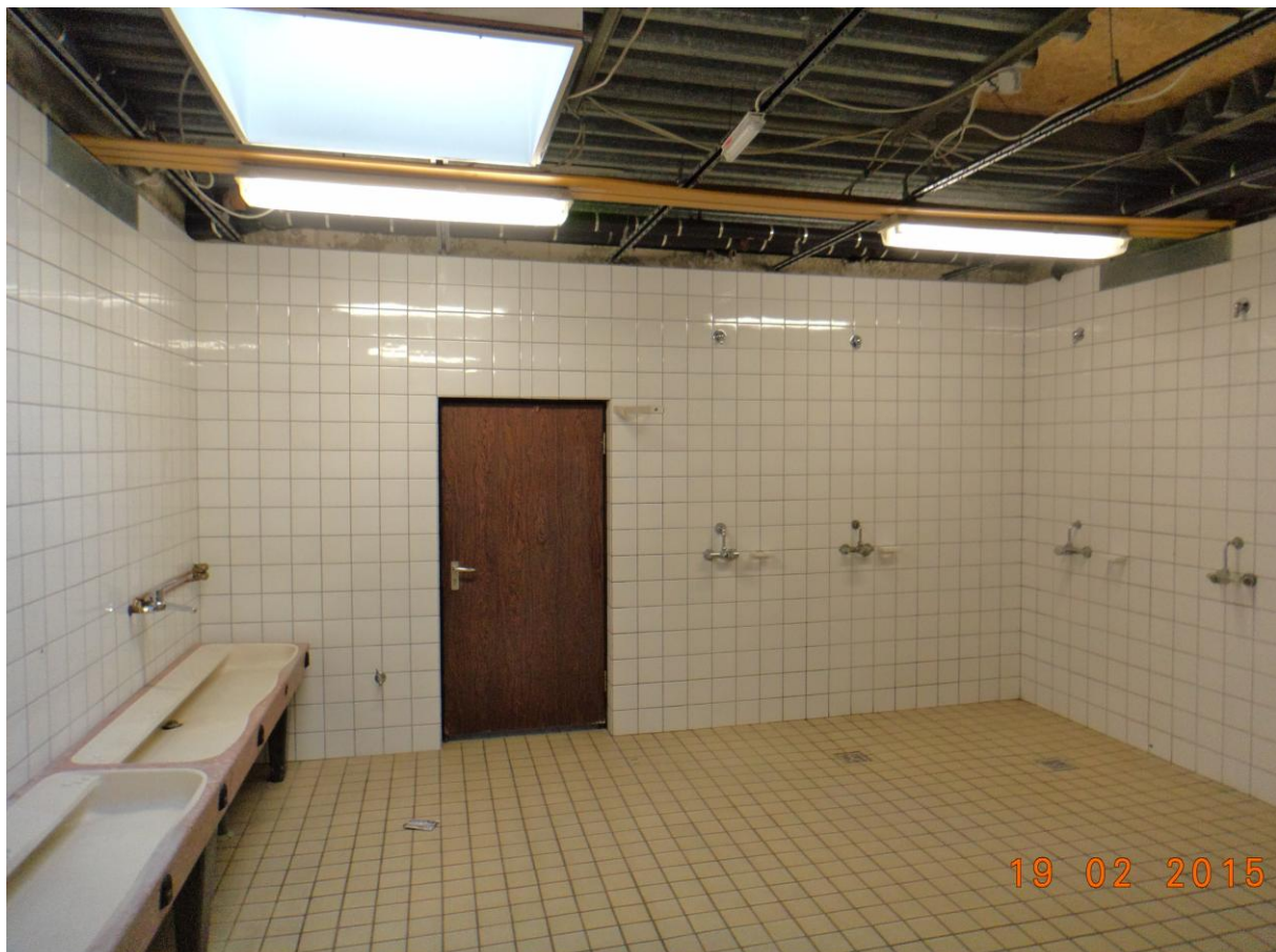
Bild 02: Duschbereiche vor Beginn der Sanierung
