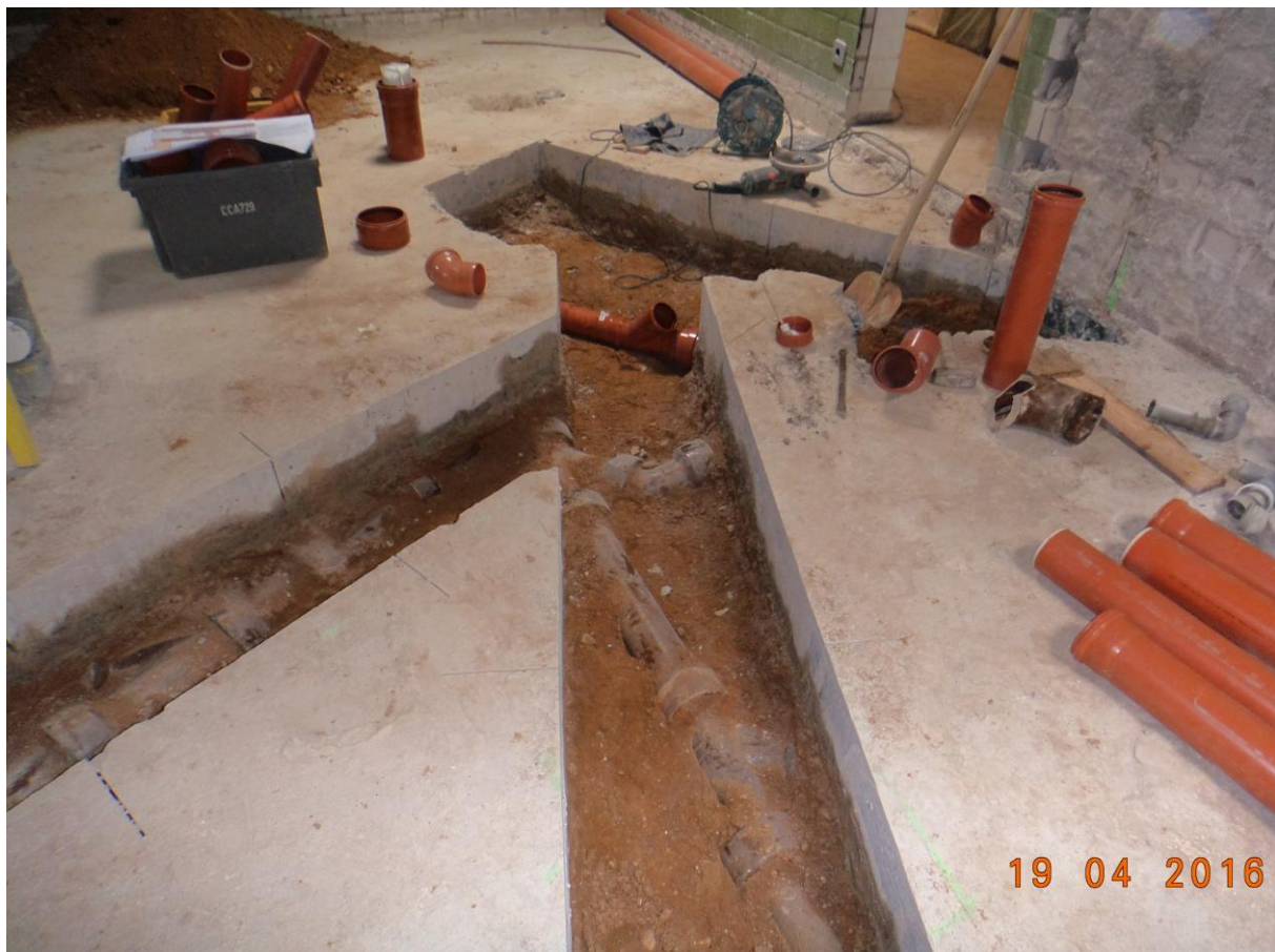
Bild 06: Verlegung neuer Grundleitungen
