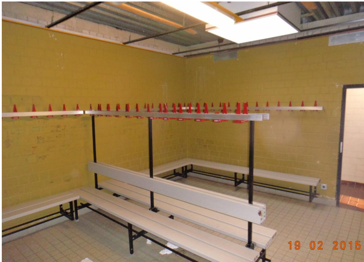
Bild 01: Umkleiden vor Beginn der Sanierung
