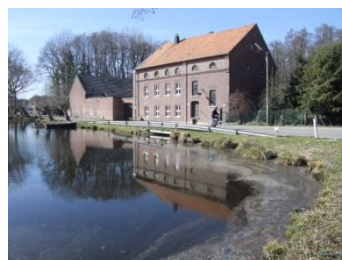
Einleitungsstelle in den Weiher „Buschmühle“ (o.l.) und Mühlenbach (u.r.)
