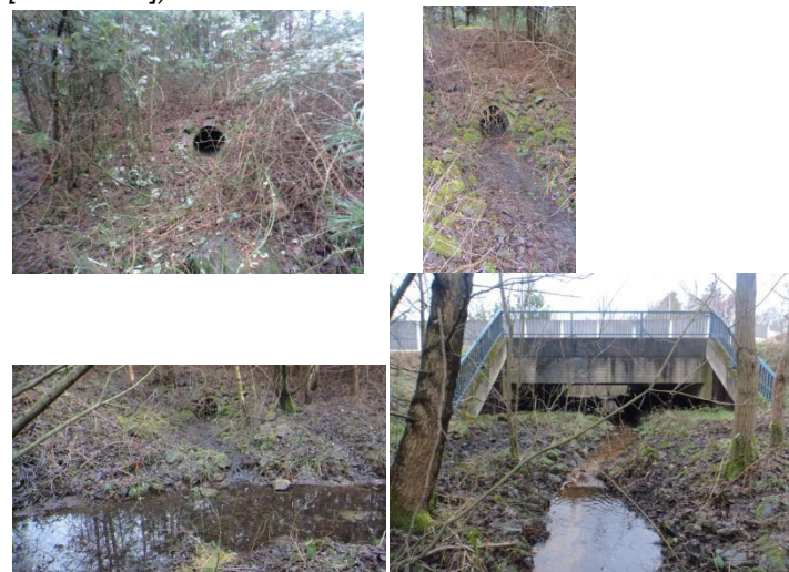
Einleitungsbauwerk in das RKB 1 (o.l.), Einleitung aus dem RKB 1 (o.r.), Einleitungsstelle in den Helpensteiner Bach (u.l.), Helpensteiner Bach (u.r.)
