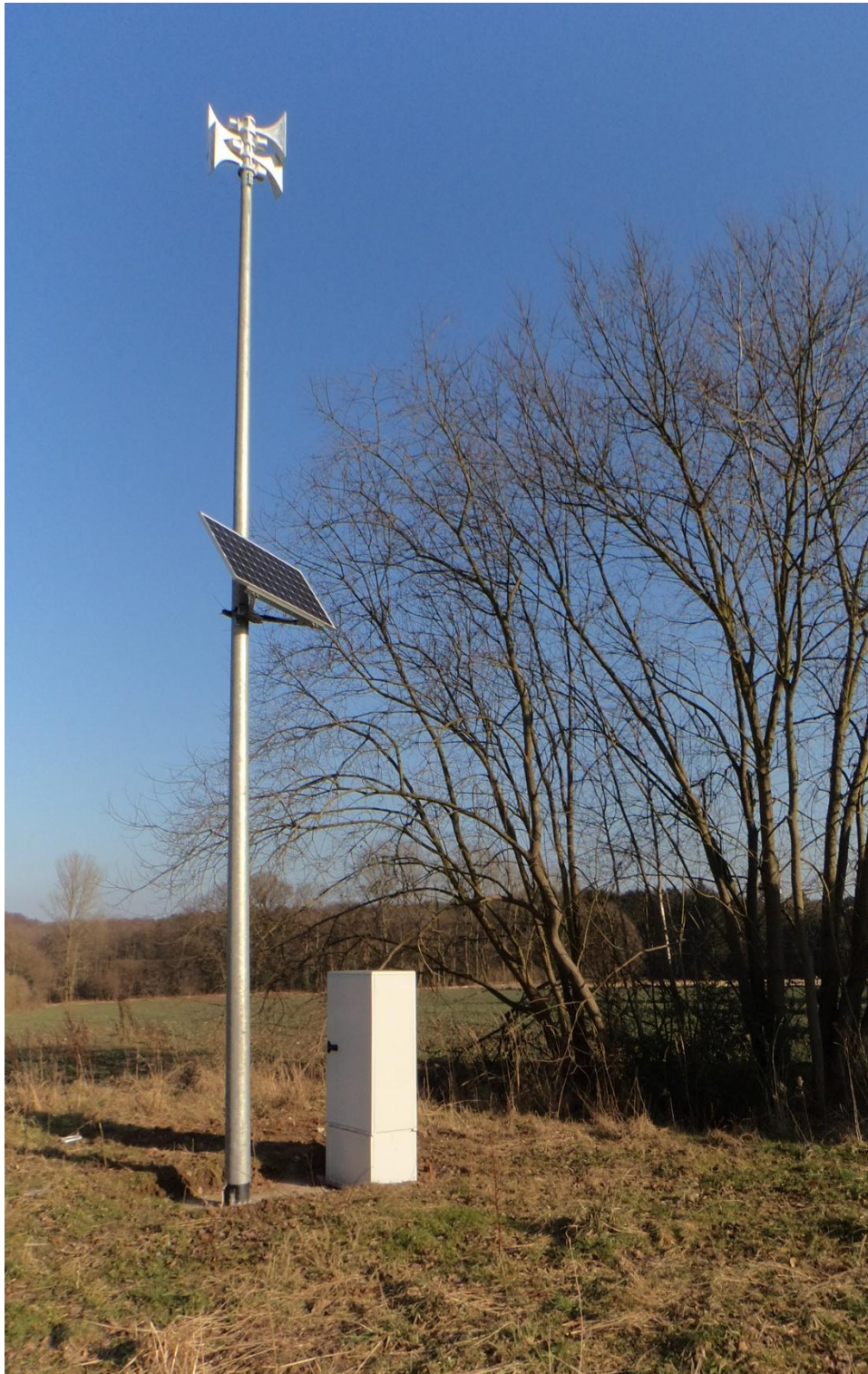
Sirenenmast – Arsbeck Zum Wasserturm
