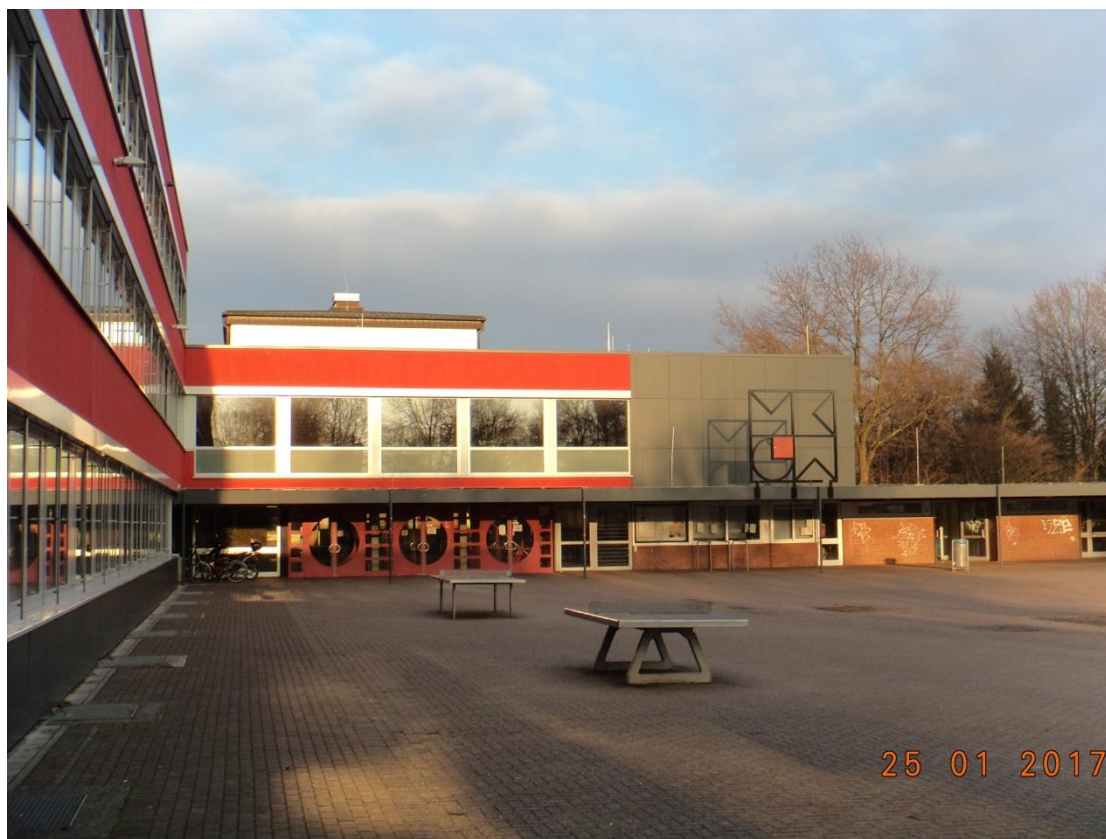
Foto 01: Eingangsbereich Maximilian-Kolbe-Gymnasium, Außenansicht
