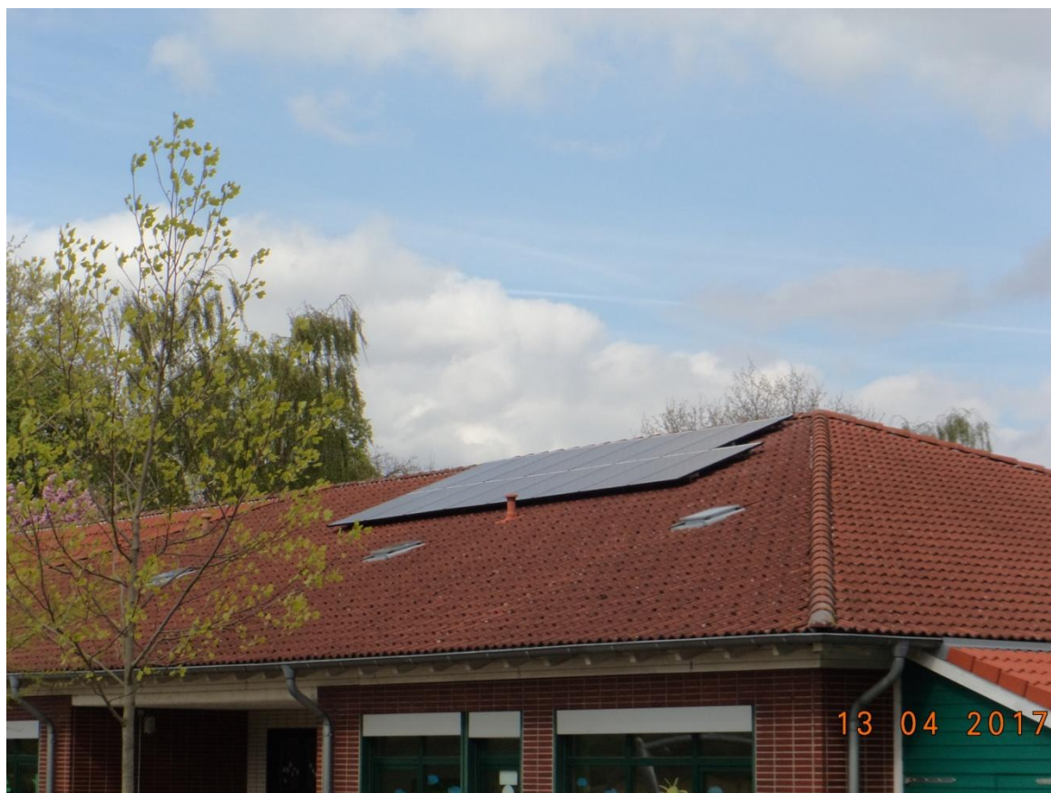
Foto 06: Kindergarten Klinkum, westliche Dachfläche
