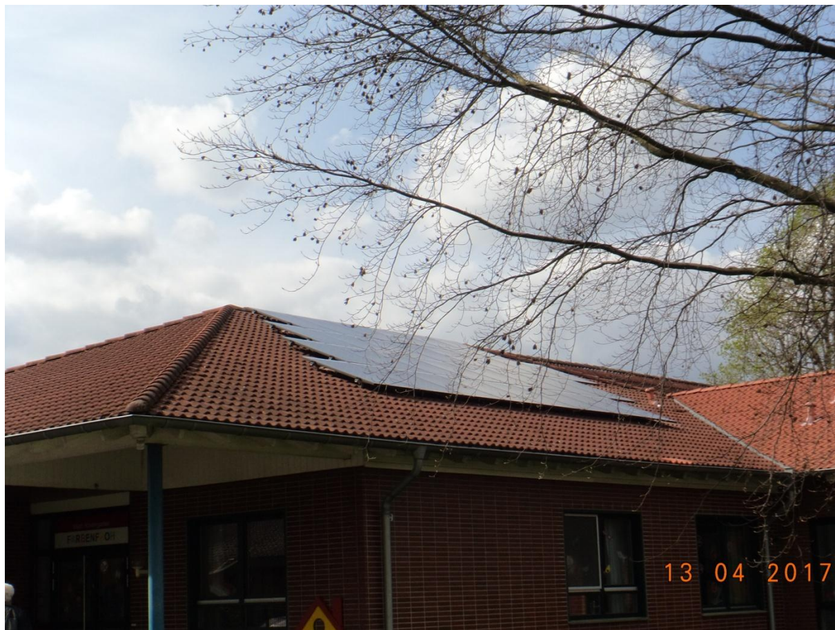
Foto 05: Kindergarten Klinkum, östliche Dachfläche
