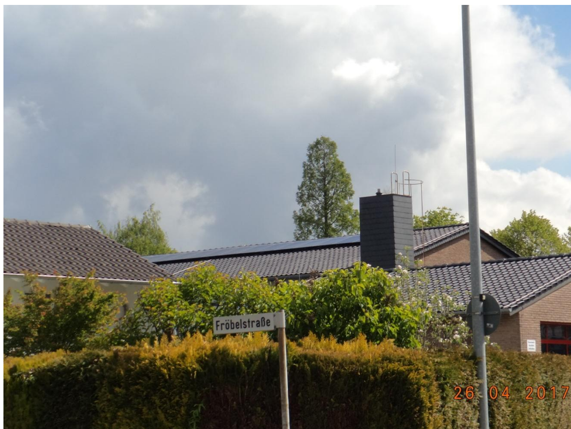
Foto 04: Grundschule Rath-Anhoven, Dachfläche Nord-West
