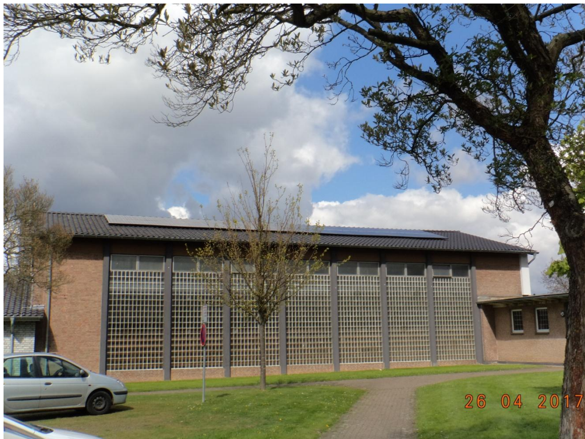
Foto 03: Grundschule Rath-Anhoven, Dachfläche Süd-Ost
