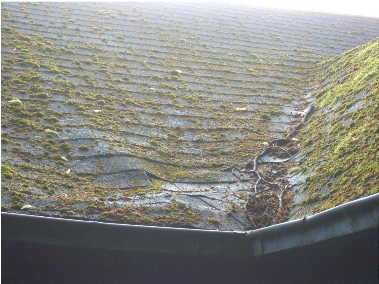
Dachfläche Friedhofshalle Arsbeck
