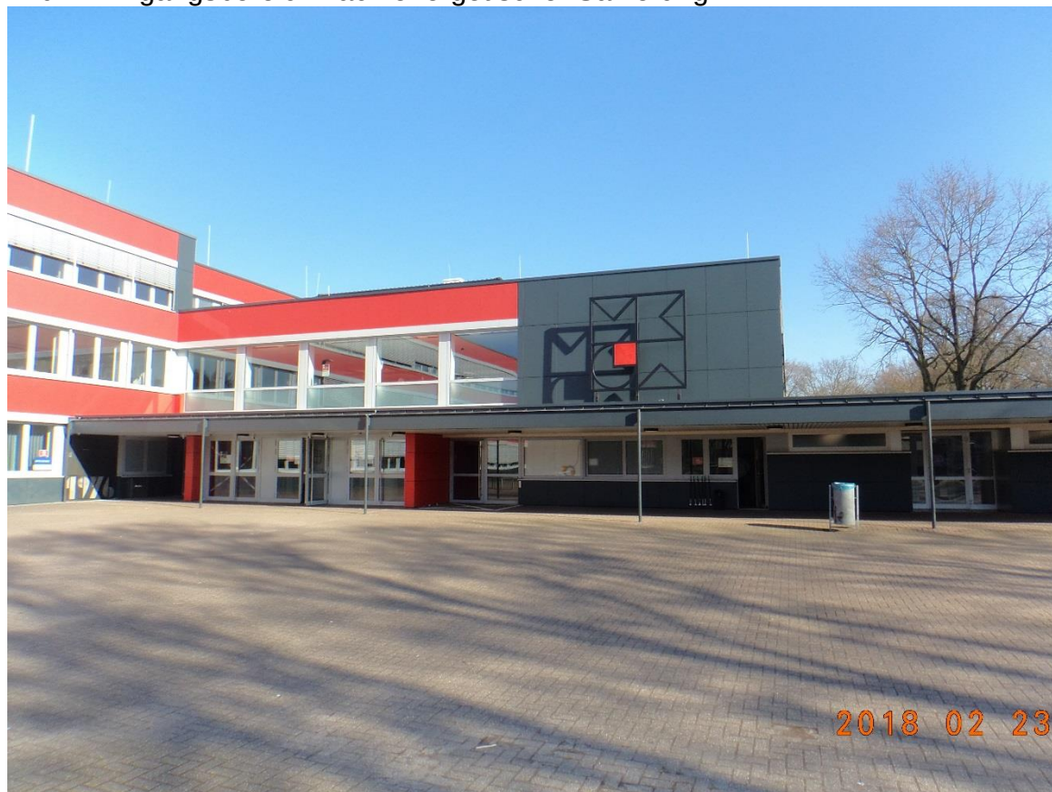
Bild 1: Eingangsbereich nach energetischer Sanierung
