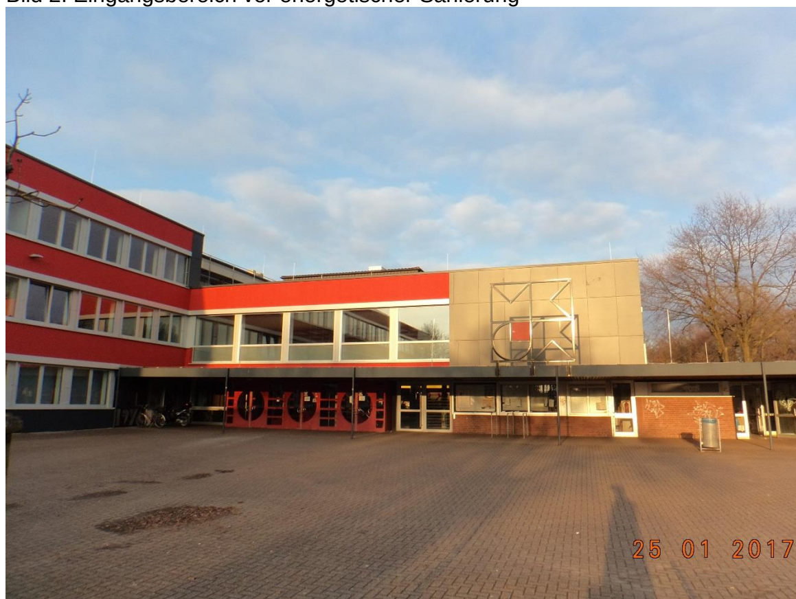
Bild 2: Eingangsbereich vor energetischer Sanierung
