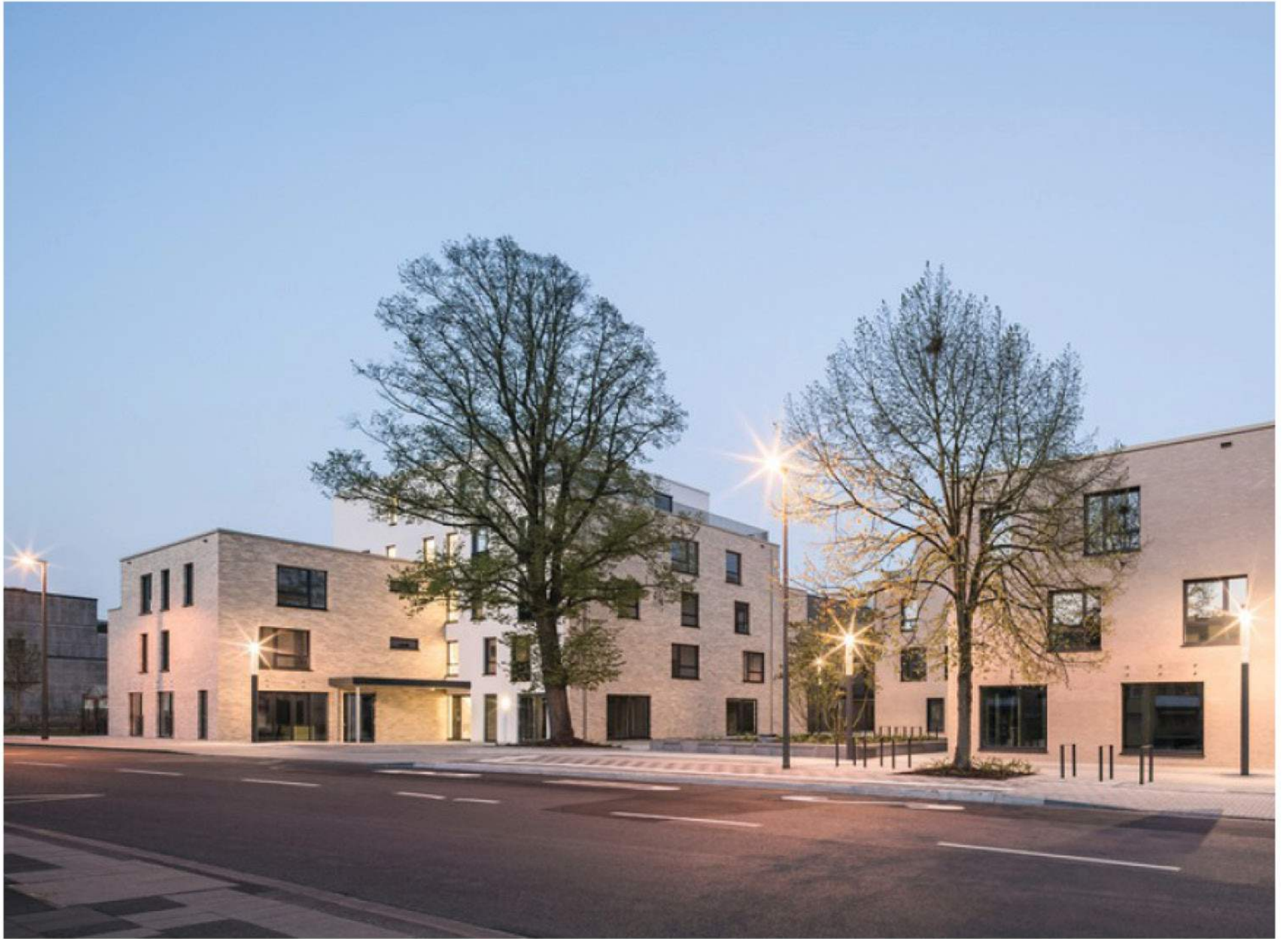
Stadtquartier Merheim Köln, 2015, GATERMANN + SCHOSSIG, Bebauung mit EG-Nutzung
