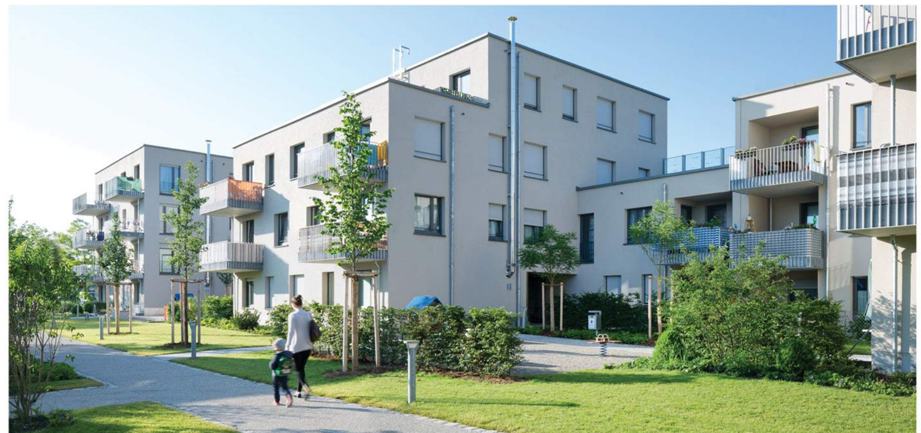
Lärmschutzbebauung Bad-Schachener-Straße München, 2009, 1. Preis, florian kriegler architektur und städtebau
