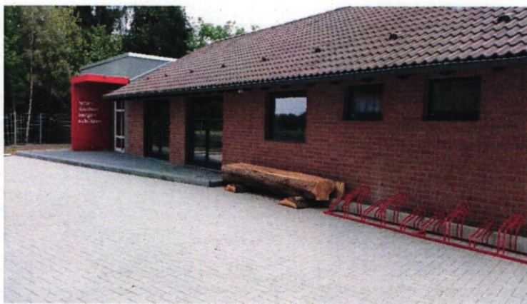
Anbau mit neuem Zugang.
