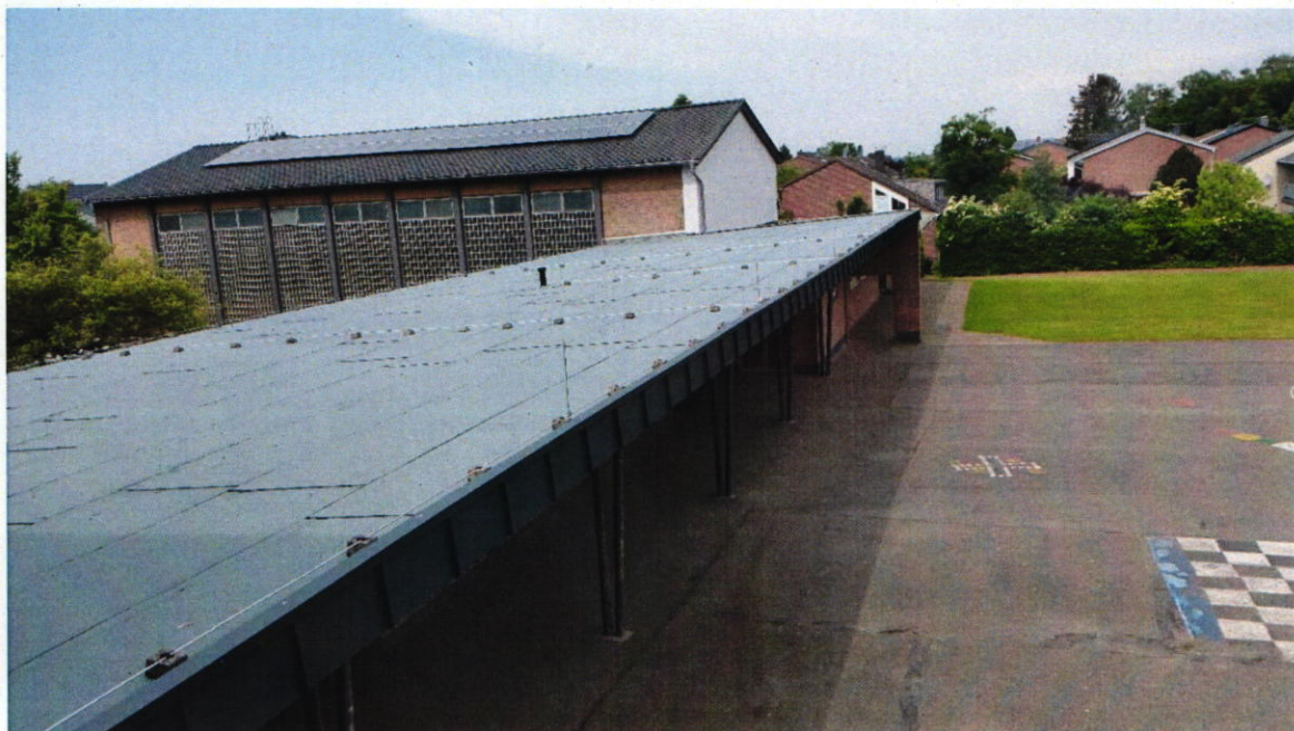
Kastanienschule Rath-Anhoven: Fertigstellung Flachdachsanierung
