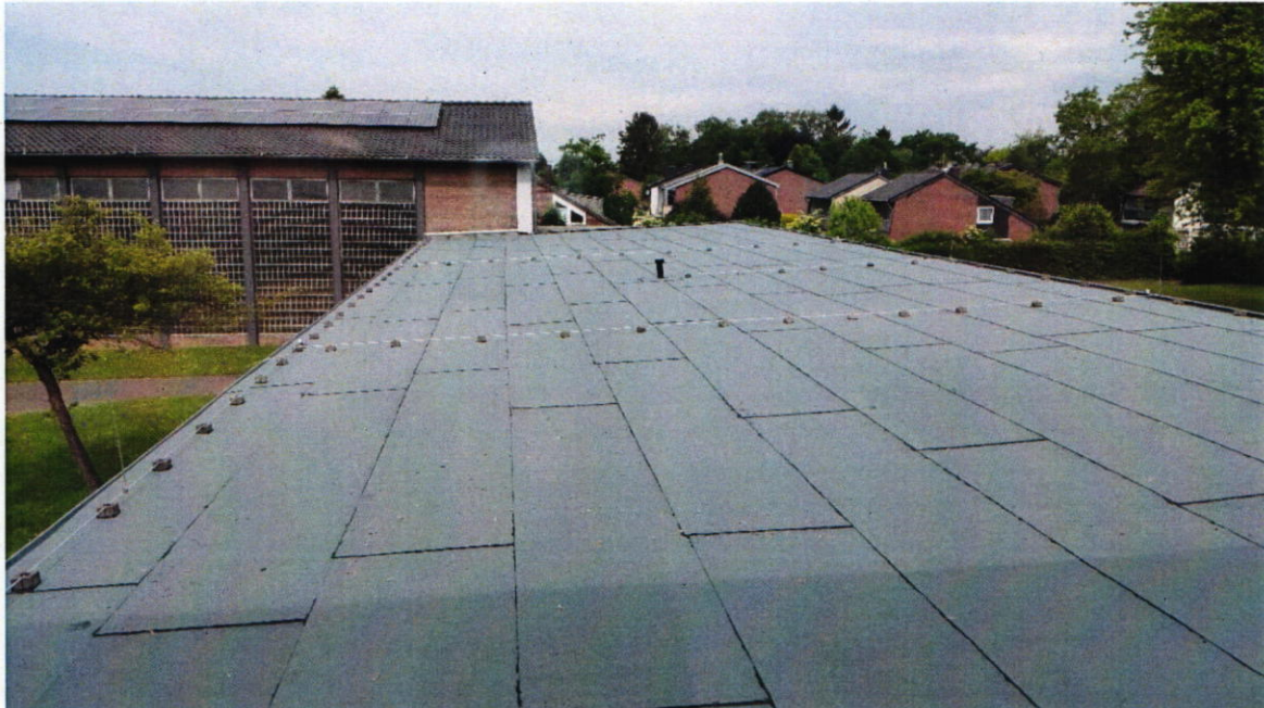
Kastanienschule Rath-Anhoven: Fertigstellung Flachdachsanierung
