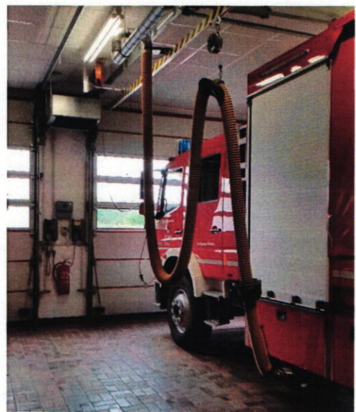
Abgas-Absaug-Anlage
