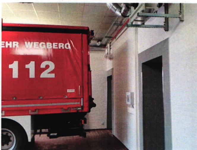
Fahrzeughalle mit den neuen Zugängen zum Anbau
