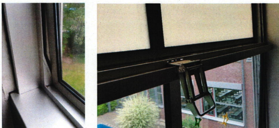
Edith-Stein-Realschule – Detailfotos: Führungsschiene und Fenstergriff
