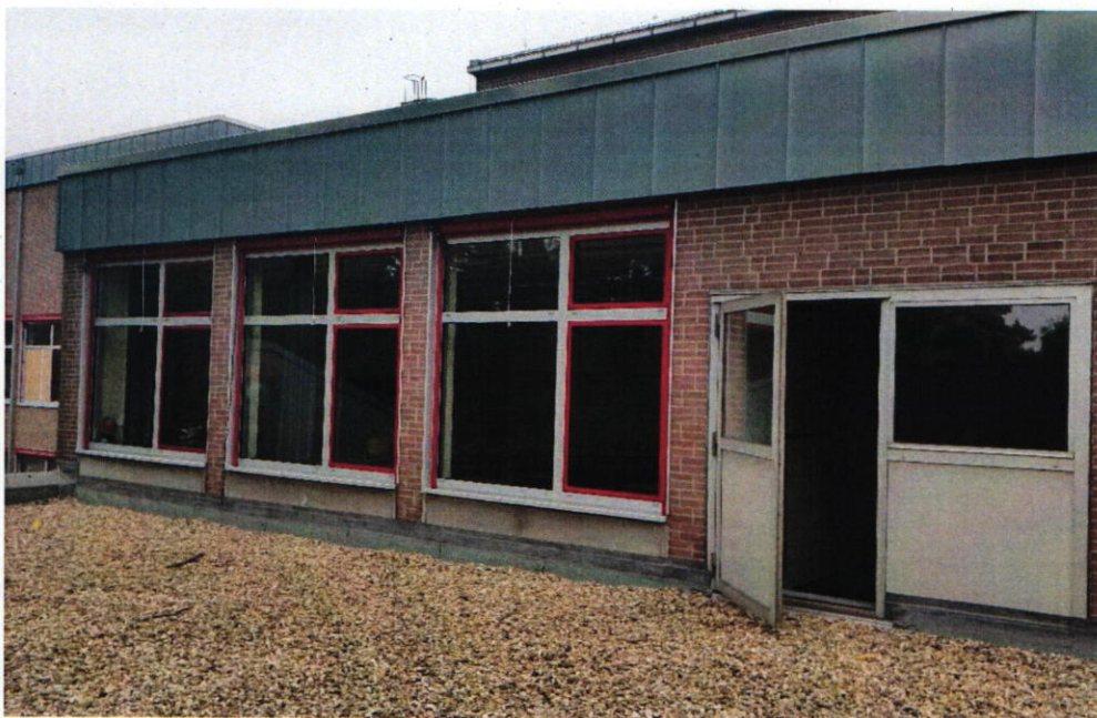
Edith-Stein-Realschule – Außenansicht: 1.OG Klassenraum mit Sonnenschutz
