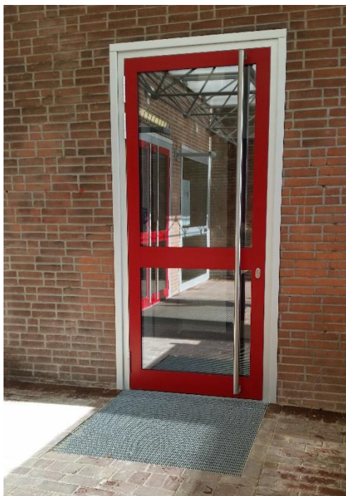
Neuer Zugang WC-Anlagen Eingangspodest
