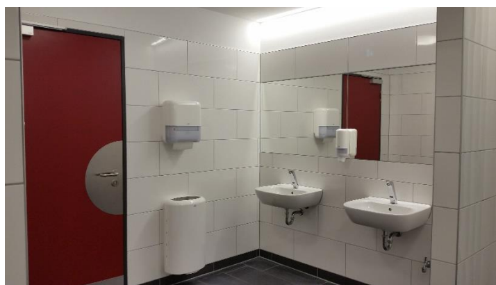
Jungen-WC, Waschtischanlage Vorraum
