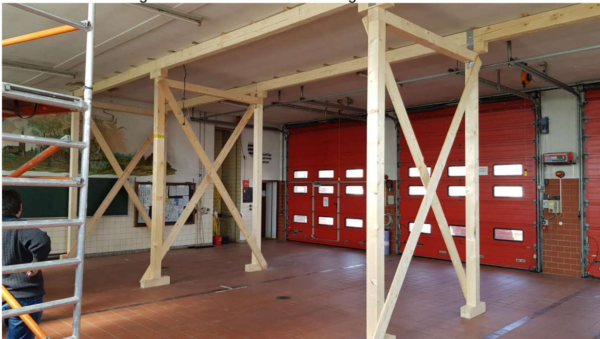
Bild 4: Unterstützungskonstruktion in der Fahrzeughalle
